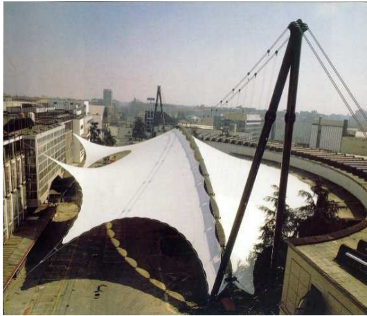
Figura 1.14: copertura piazzale Italia, Milano, 1986 ( www.canobbio.com )
