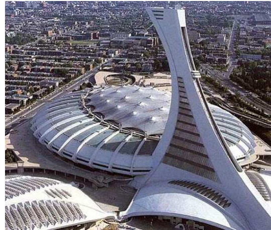
Figura 1.15: copertura stadio di Montreal, 1987 ( www.agencetallibert.com )
