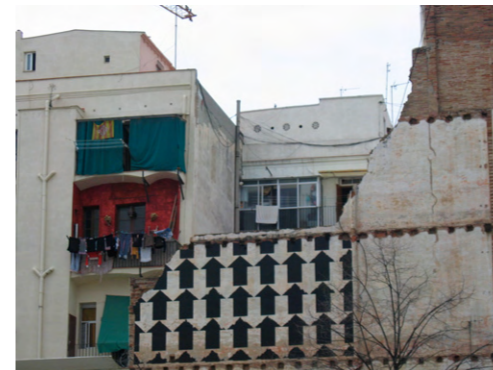
Un esempio dello stato di degrado dell'edificato nella Ciudad Vella
