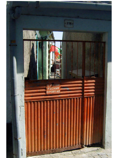
Ingresso ad una ilha con porta chiusa
