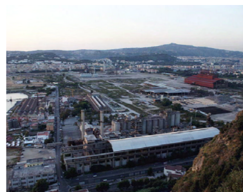
Veduta dell'ex area industriale dell'Italsider, si estende per un'area grande quanto il centro storico della città
