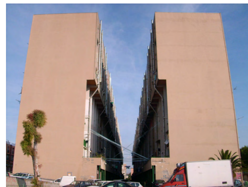
Complesso residenziale di San Giovanni Teduccio (vista laterale)
