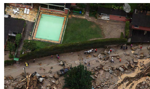
Danni provocati dalle alluvioni del Gennaio 2011
