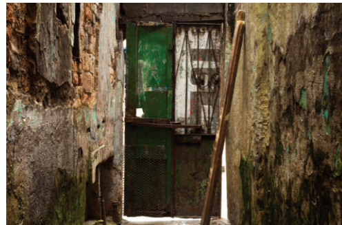
Una porta d'accesso al corticos vista dal corridoio interno.
