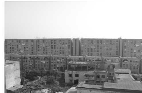
Complesso residenziale di San Giovanni Teduccio (vista Frontale)
