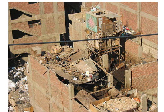
Gli edifici sembrano sempre in fase di costruzione. Mancano completamente le finiture esterne sono lasciati incompleti in previsione di
