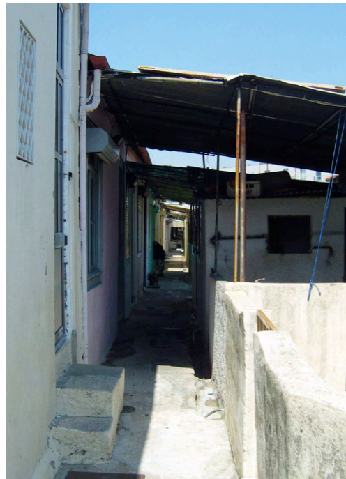
Scorcio del corridoio di una ilhas, sulla destra i bagni comuni
