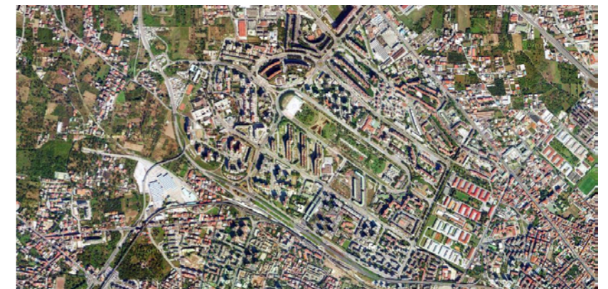
Veduta dal satellite del quartiere di Scampia. A Sud un braccio della tangenziale separa il quartiere dal centro della città ed è completamente assente il sistema di connessione pedonale pertinenziale.
