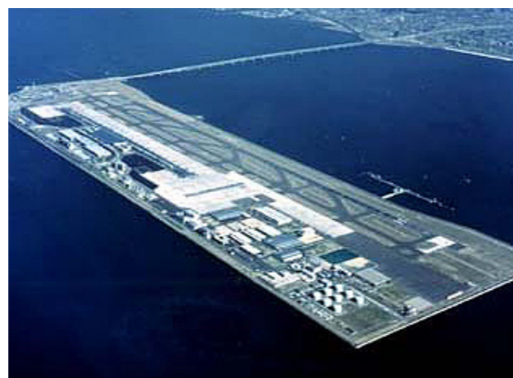
30. L'aeroporto Kansai di Osaka è stato costruito su un'isola artificiale appositamente costruita per l'aeroporto.
