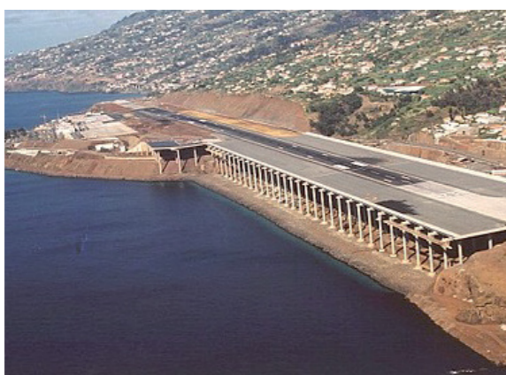
31. L'aeroporto dell'isola portoghese di Madeira ha una parte della pista di atterraggio che appoggia su un pontile sospeso su dei pilastri di cemento.
