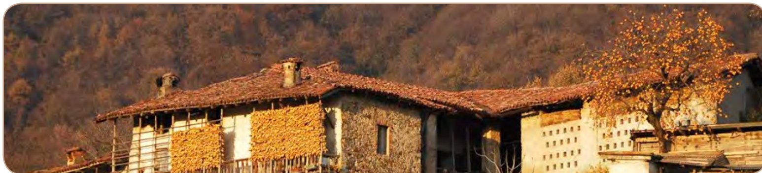
38. Esempio di edificio rurale nella Valle
