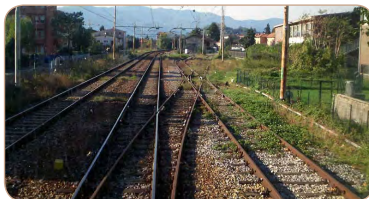
3. Stazione ferroviaria di Cisano - Caprino
