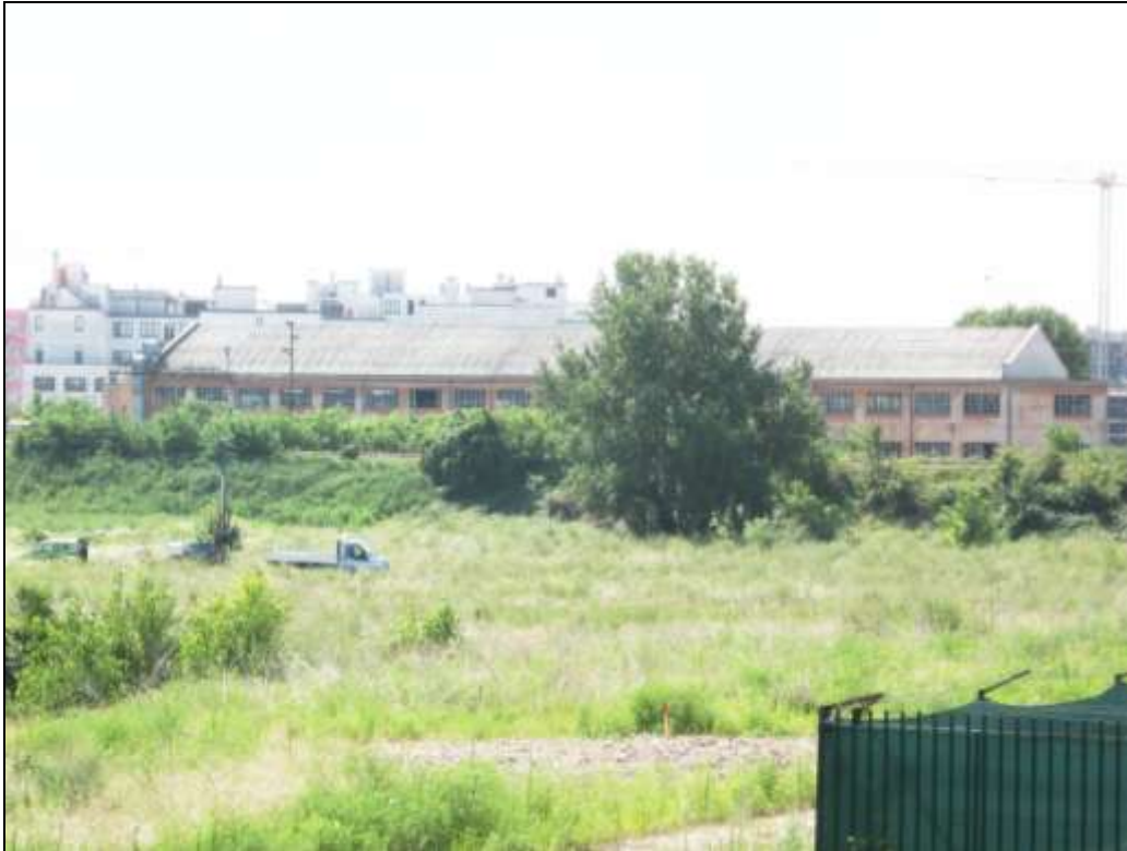
2 – Stato di fatto: facciata nord
