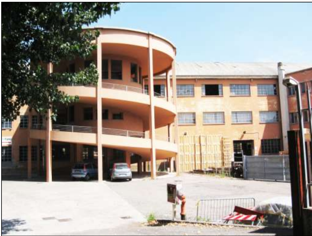
3 – Stato di fatto: facciata sud
