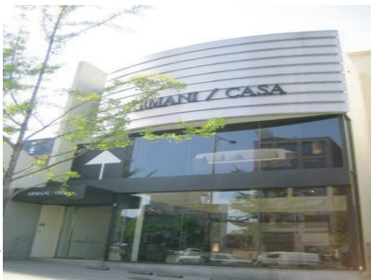
Fig. 46 - Showroom Armani Casa Los Angeles (Stati Uniti D'america)
