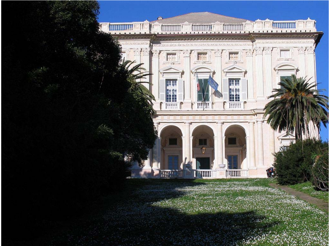
Figura 228: Genova. Villa Cambiaso. Fronte principale.
