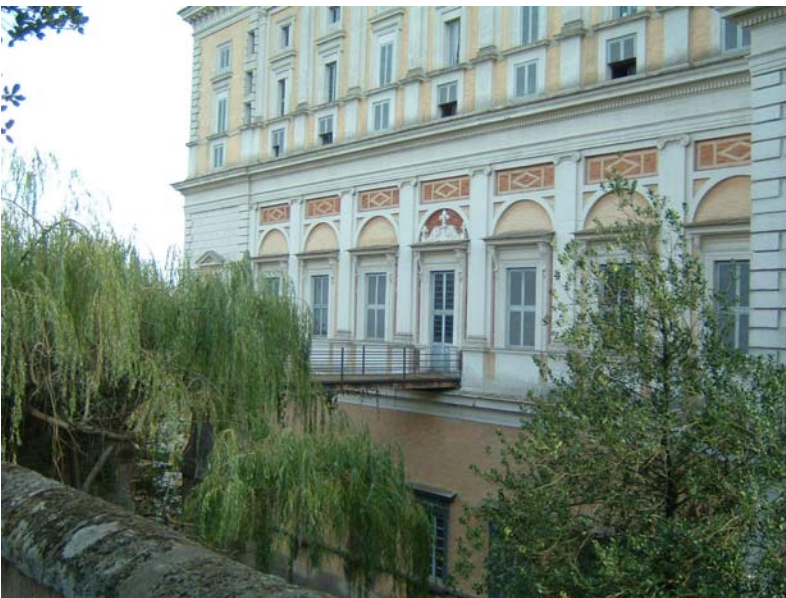
Figura 88: Caprarola. Palazzo Farnese. Ponte sul fossato, di collegamento con i giardini superiori.
