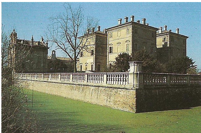
Figura 217: Busseto. Villa Boffalora o Pallavicino. Veduta generale del complesso (da A. Mavilla 1995, p. 37).
