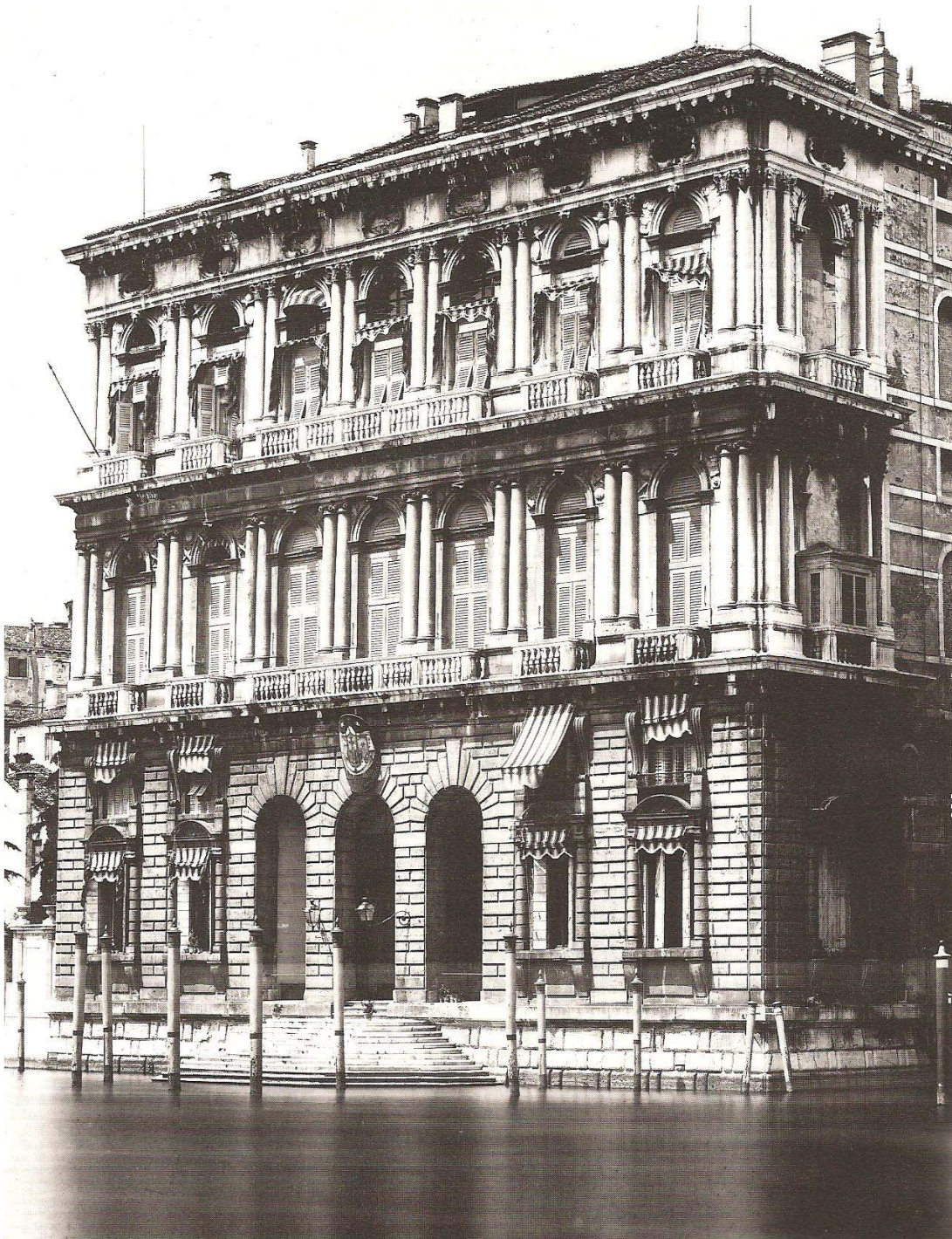
Figura 317: Venezia. Palazzo Corner alla Ca' Granda. Facciata in una fotografia ottocentesca (da G.Romanelli 1993, p.124). Dalla perfetta calma dell'acqua del canale emerge la possente scalinata sovrastata dalla loggia.
