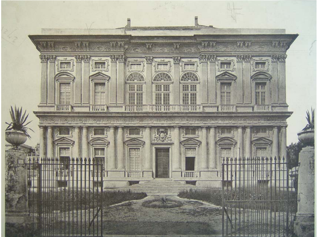
Figura 255: Villa Imperiale Scassi. Foto d'epoca della facciata principale (da R. Reinhardt 1886, tav. 82).
