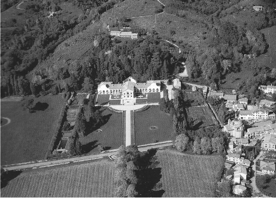
Figura 177: Maser. Villa Barbaro. Veduta aerea della villa. (da: M. Azzi Visentini 1995, p. 275). Il paese, sulla destra, sembra non avere relazioni con l'asse della villa.
