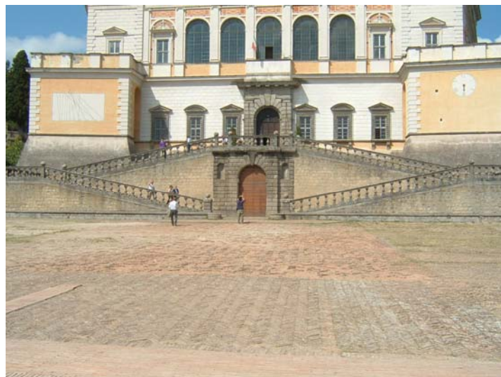
Figura 82 : vista del palazzo dal secondo livello, con l'ingresso per la carrozze e, in alto, gli elementi di apertura al contesto: la loggia al secondo piano e le terrazze.
