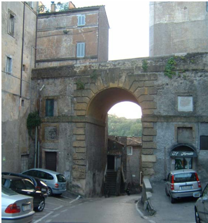
Figura 79: il ponte delle Monache, costruito per superare un dislivello più a monte.
