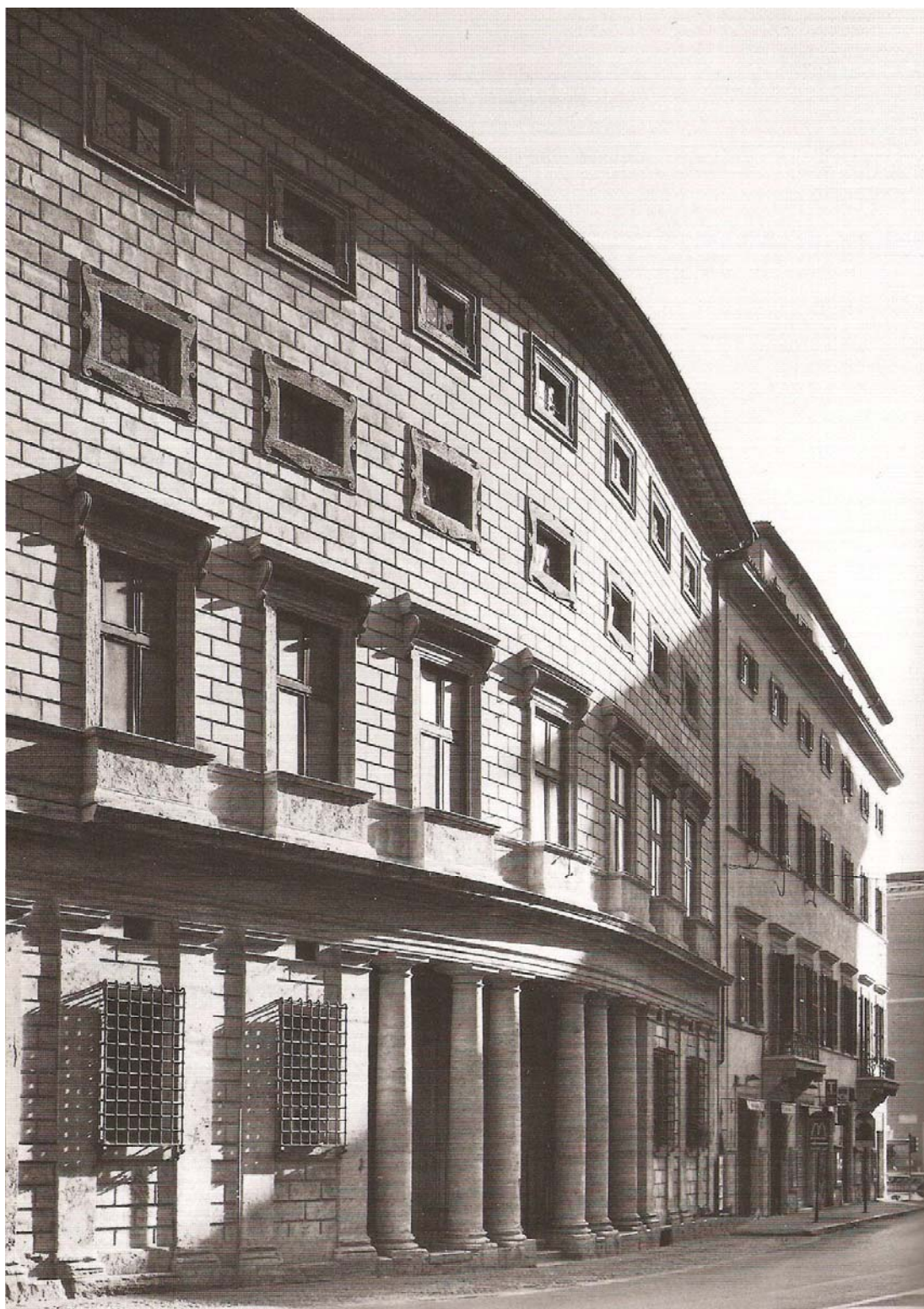
Figura 34: Roma. Palazzo Massimo alle Colonne. Facciata (da V. Cafà 2007, p.20).
