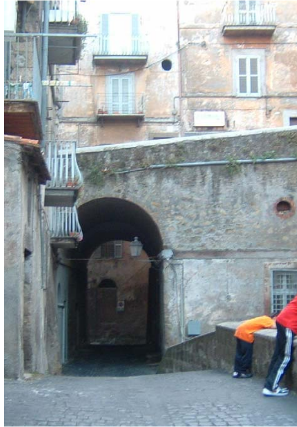
Figura 78: il ponte più a valle sotto la via Diritta, costruito per superare un dislivello del terreno.
