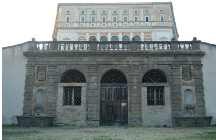
Figura 81: il primo terrazzamento, con l'ingresso al livello più basso, dominato dal palazzo.
