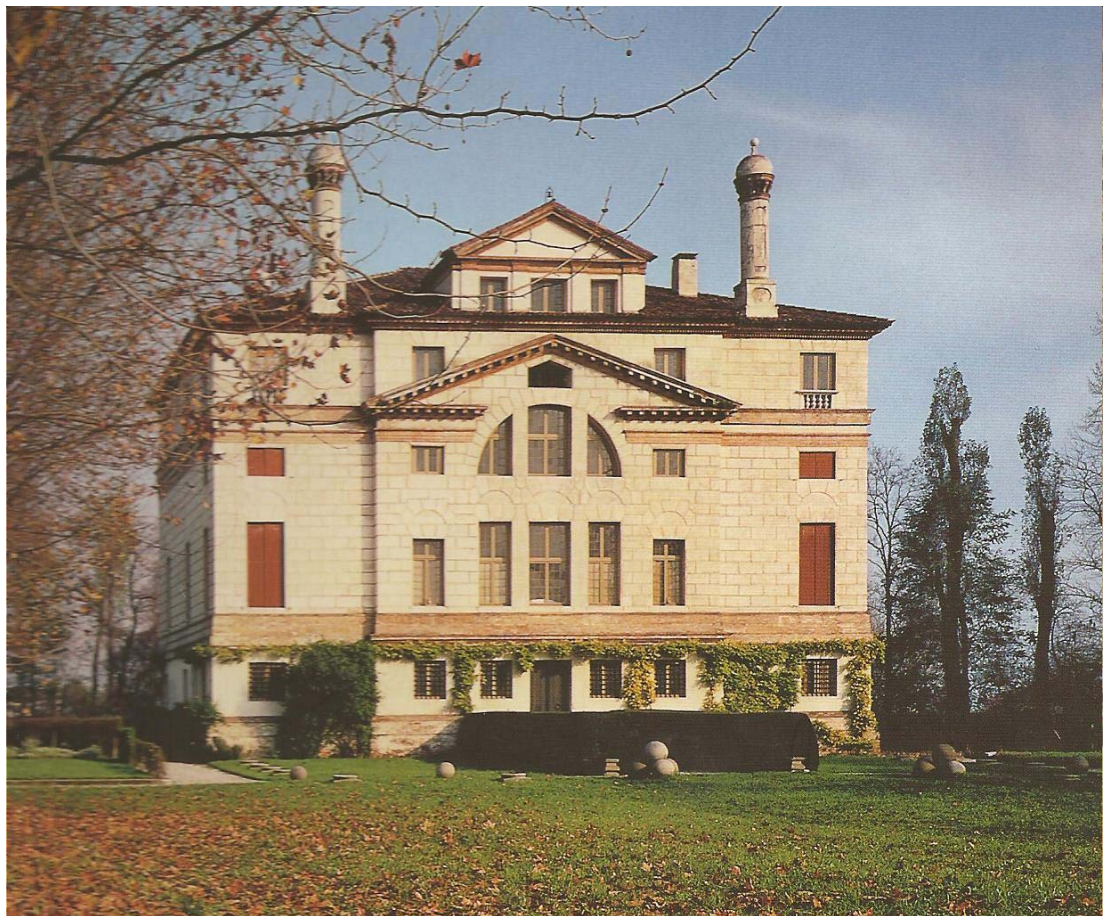
Figura 189: Malcontenta di Mira. Villa Foscari. Veduta del prospetto sul retro (da T. Pape, M. Wundram 2008, p. 138).
