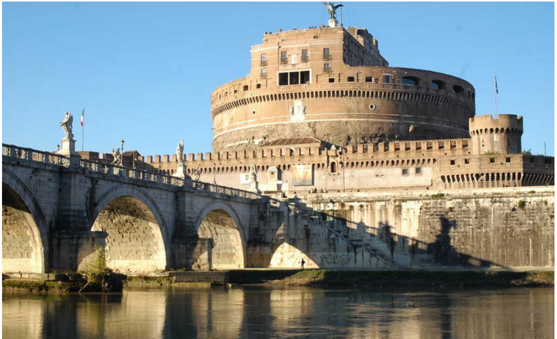
Figura 43: Roma. Castel sant'Angelo. Si noti il ponte in linea con l'ingresso e la loggia che si apre lungo lo stesso asse.
