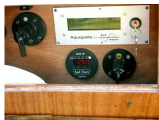
[82] Un particolare del quadro di controllo della barca elettro solare
