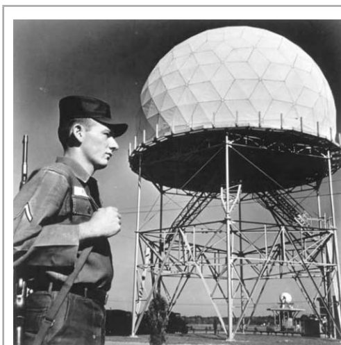
Fig. 5.12 Esempio di Cupola Geodetica utilizzata in ambito militare
