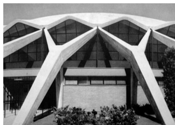
Fig. 3.9 - Particolare dei cavalletti a Y
