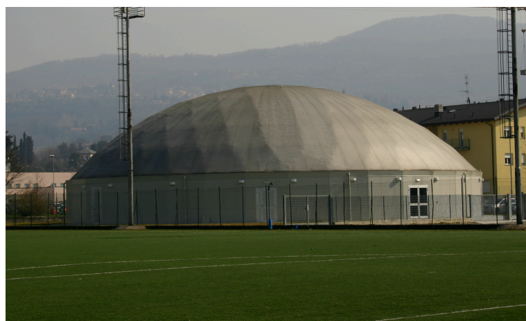
Fig. 10.1 e 10.2 - Vista interna ed esterna della Cupola geodetica collaudata in esame
