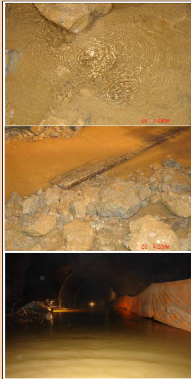
Figura 2.38: Foto delle venute d'acqua nel disastro della galleria Qiyueshan (Li et Al. 2010).
