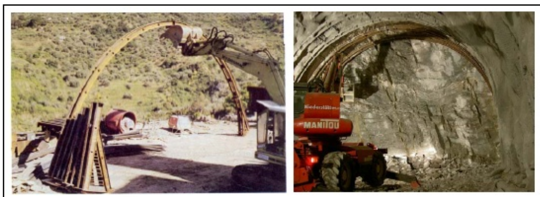
Figura 6.25: Centina in fase di montaggio e installata in galleria (Monaco 2009).
