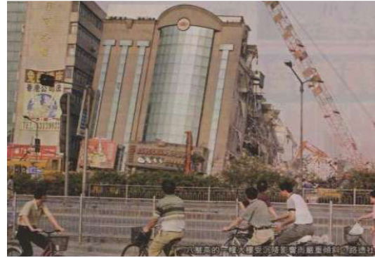
Figura 2.44: Esempio di formazione di camini e cedimenti superficiali indotti dal tunneling (documentazione archivio Pizzarotti).
