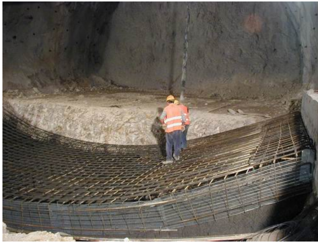
Figura 6.23: Armatura dell'arco rovescio (Grandeviabilità trieste).
