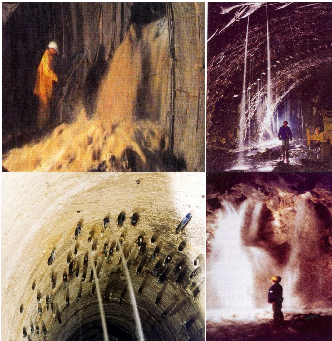
Figura 2.35: Esempi di venute d'acqua in gallerie in corso di escavazione (Pizzarotti 2007).
