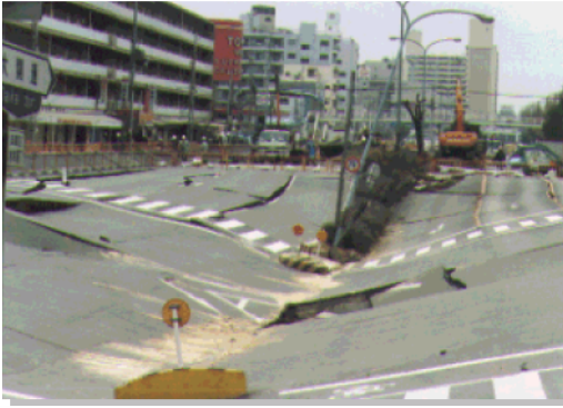
Figura 2.44: Esempio di formazione di camini e cedimenti superficiali indotti dal tunneling (documentazione archivio Pizzarotti).
