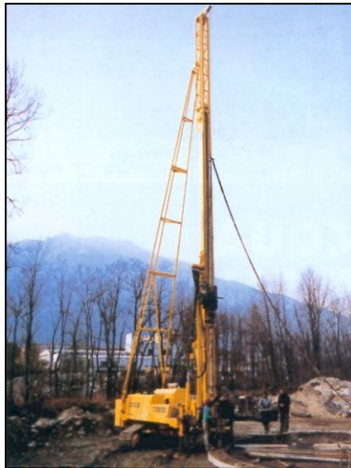
Figura 6.10: Macchina jet-grouting verticale dal piano di campagna (Scesi et Al. 2003).
