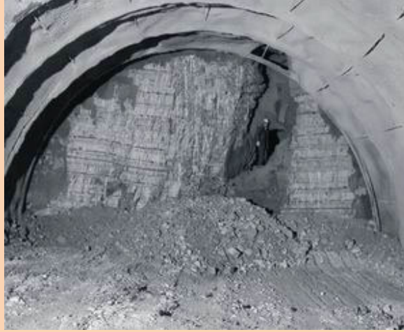
Figura 2.48: Comportamento tipico di piccole cavità carsiche parzialmente riempite con argilla e limo; Dodoni tunnel (Török et Al. 2006).
