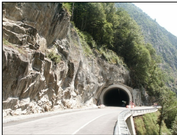
Figura 2.8: Esempio di galleria parietale(Pizzarotti 2007).
