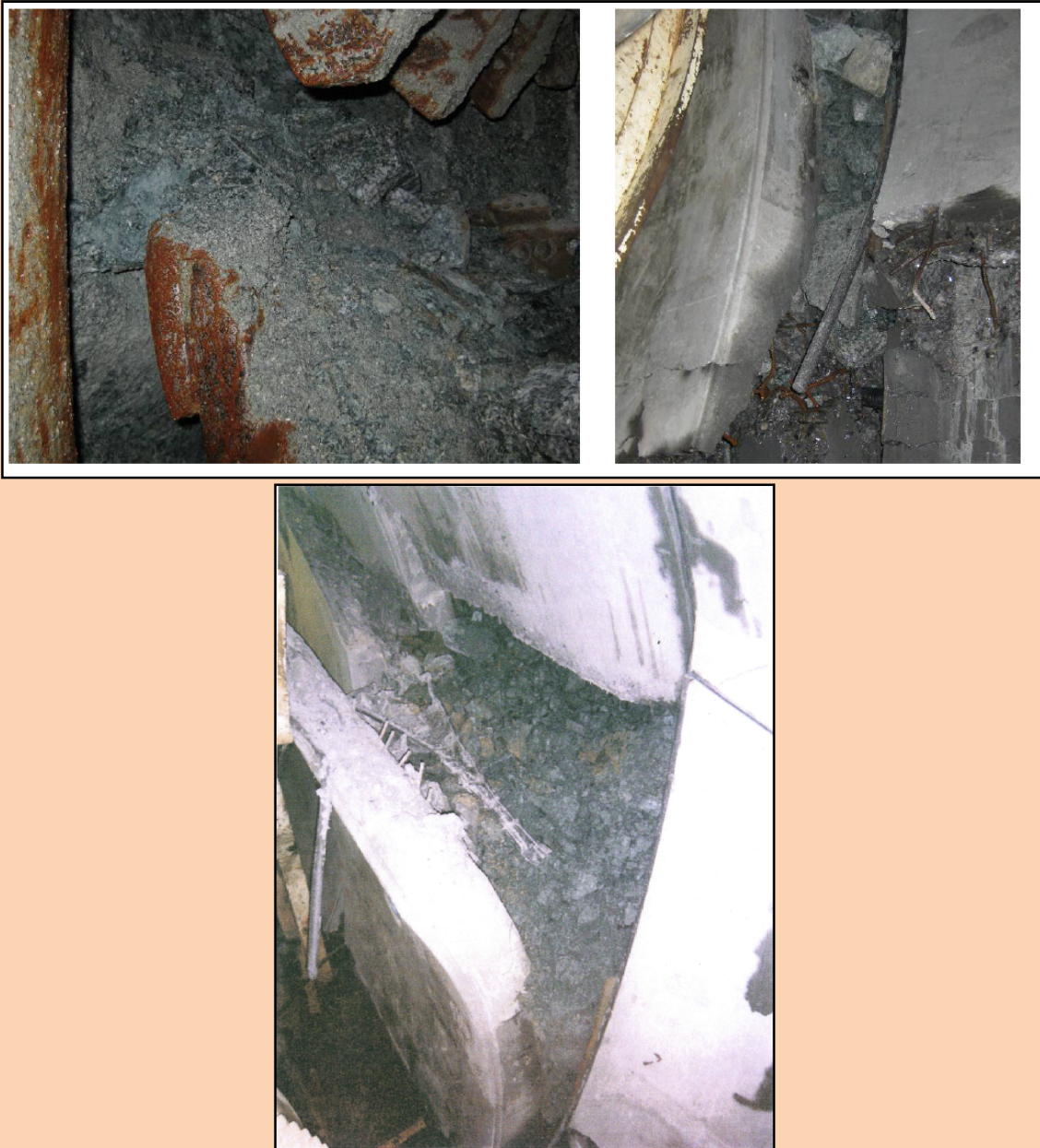
Figura 2.23: Frattura del granito al fronte (pk 6+151m) e nella parte precedente (pk 6+120m), (Relazione Tecnica Pro Iter, 2010).
