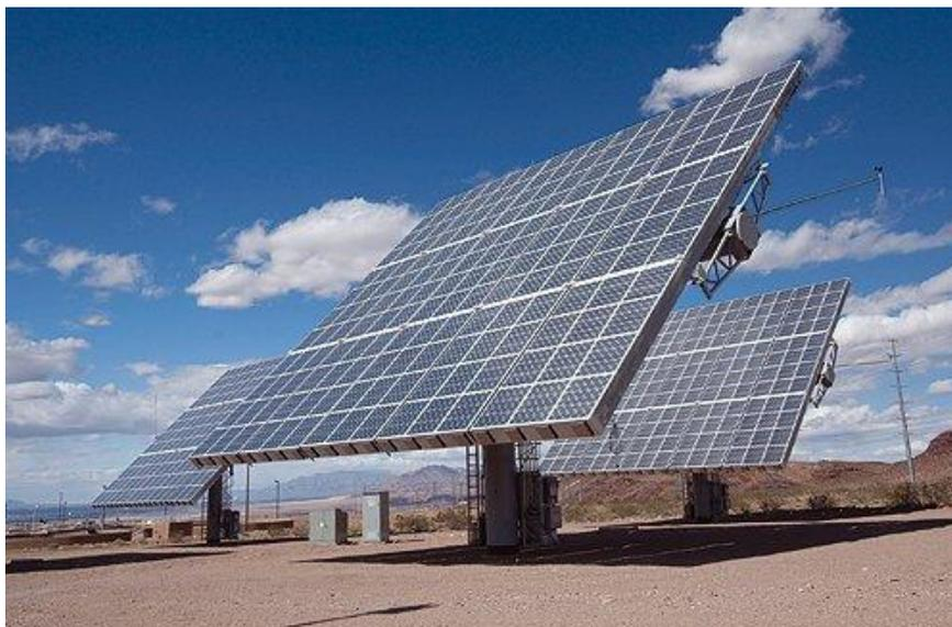
Figura 1-11 *Inseguitori per sistemi a concentrazione*
