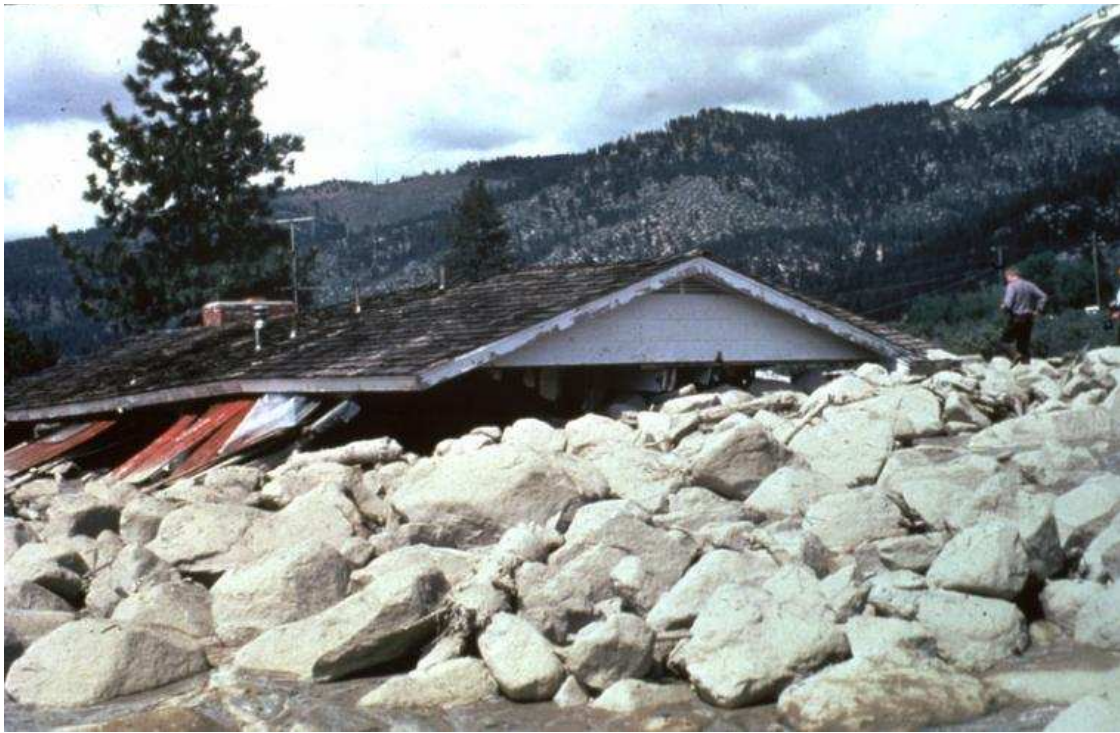
Figura 1.5 - Una casa parzialmente sepolta dai massi trasportati da un debris flow in Nevada, USA (foto USGS, maggio 1983).
