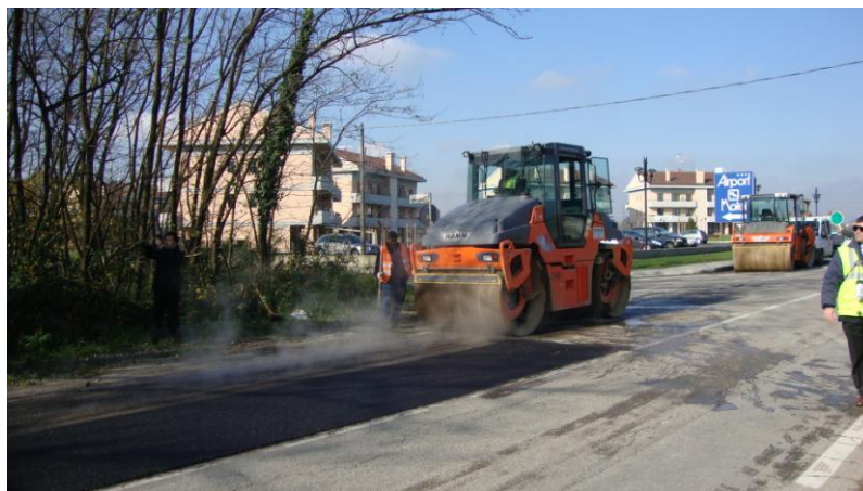
Figura 3 Rullo metallico vibrante a doppio tamburo
