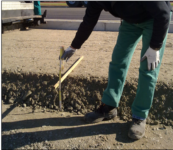
Figura 4.8- Misurazione dello spessore dello strato
