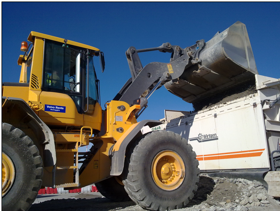
Figura 4.5- Carico degli aggregati nel miscelatore
