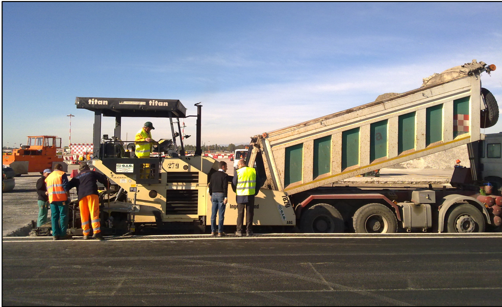
Figura 4.7- Carico della finitrice e stesa del materiale
