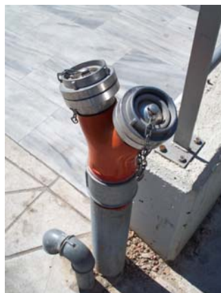
Figura 3-8 Idrante soprasuolo
