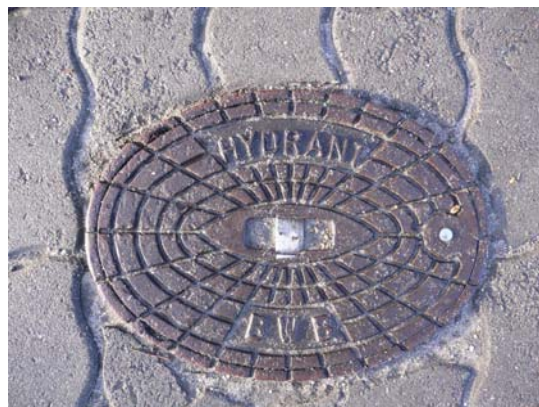
Figura 3-7 Idrante sottosuolo
