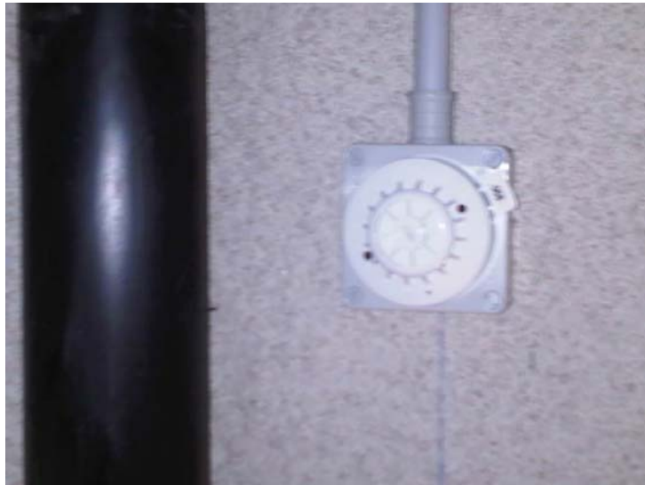
Figura 3-1 Rilevatore Ottico
