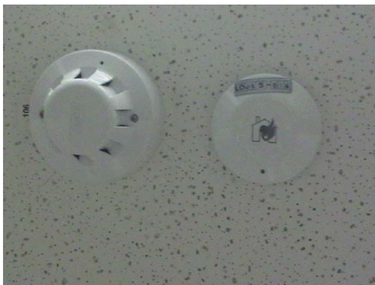
Figura 3-2 Rilevatore ottico- termico
