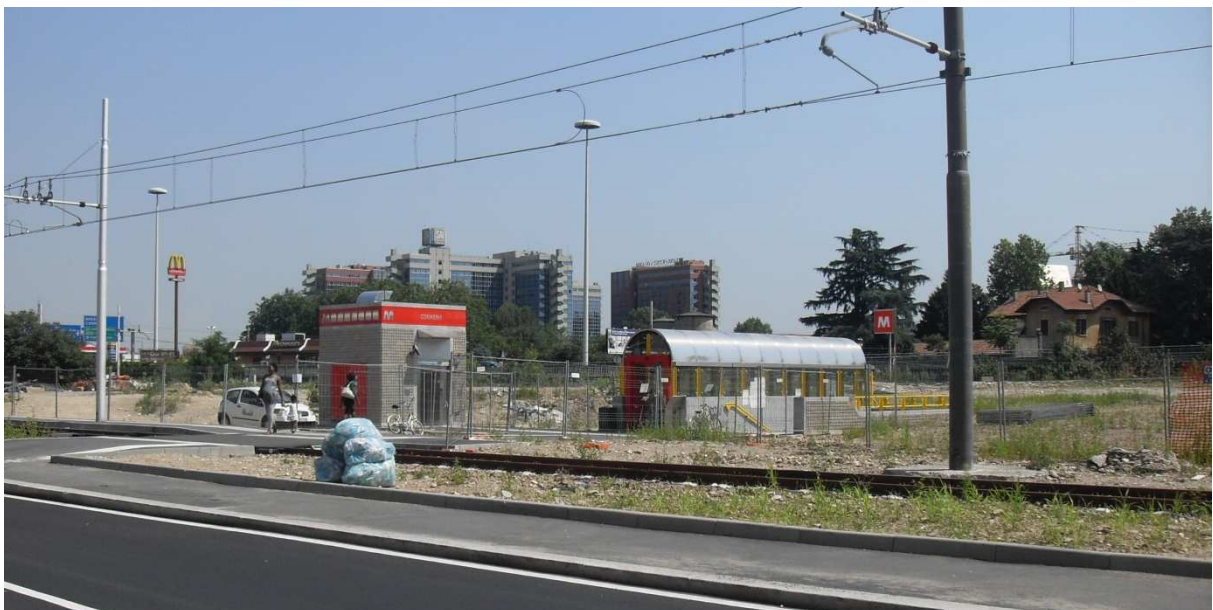
Foto 26: Stazione della Metropolitana.
