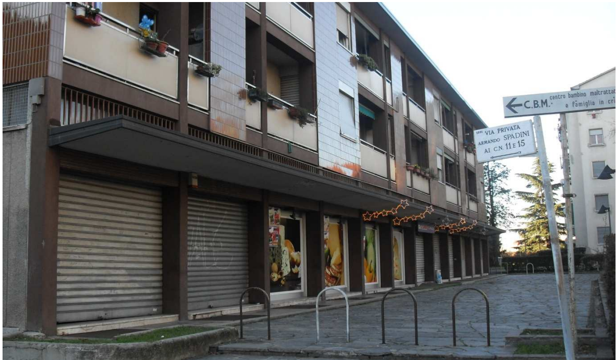
Foto 11: Vista dei negozi in via Spadini 15.
