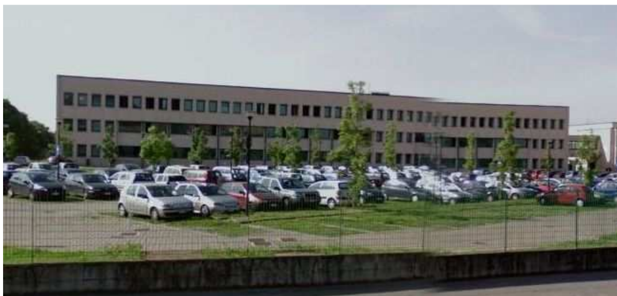
Foto 18: Istituto tecnico industriale "Lagrange".
