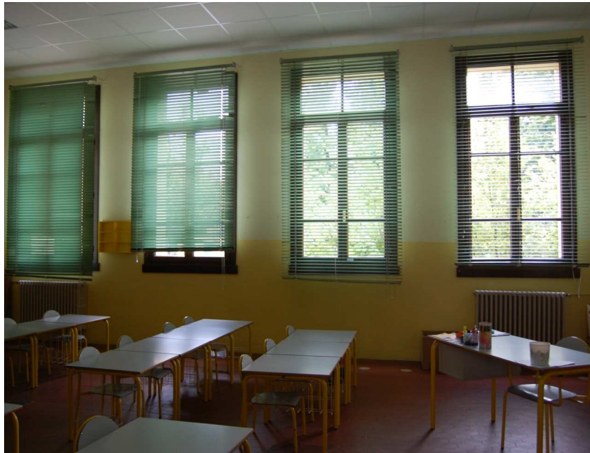
Figura 3.36 Finestre dell'aula e relativi sistemi di daylighting
