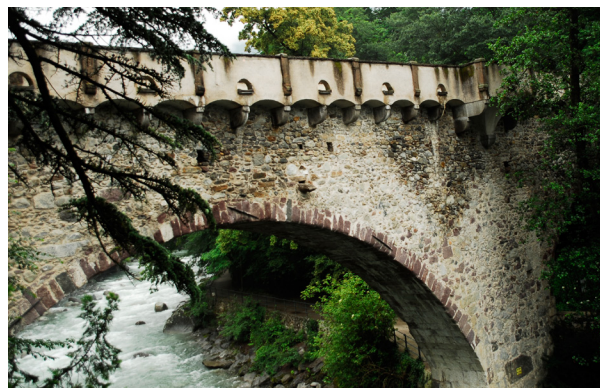
52 Il ponte romano
