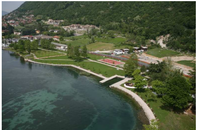
Figura 45: Il nuovo parco Lido Nettuno a Sarnico
