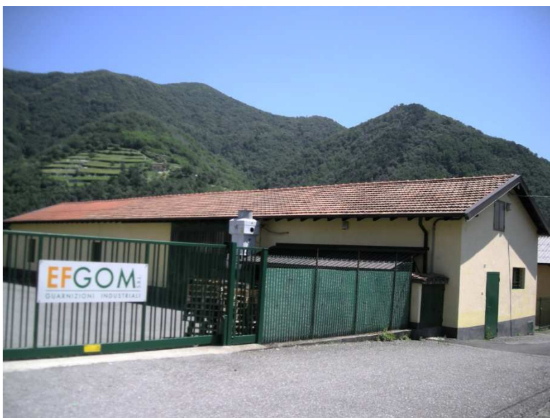
Figura 13: Edificio utilizzato prima come stalla, poi come filatura tessile e oggi come impianto per lo stampaggio di guarnizioni
