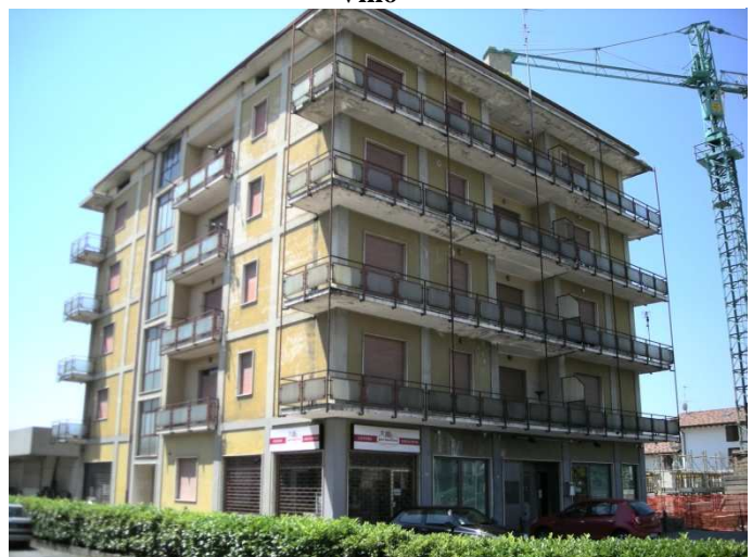
Figura 9: Edificio abbandonato lungo la provinciale che collega Castelli Calepio a Grumello del Monte
