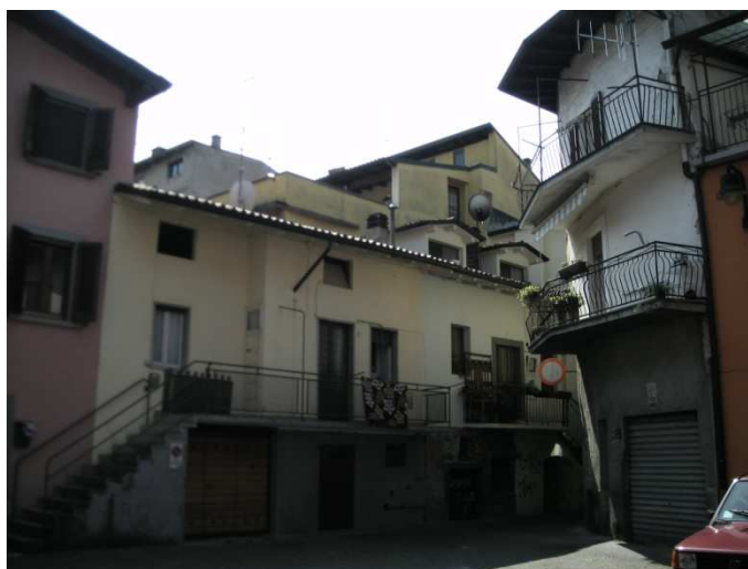
Figura 37: Edifici residenziali abitati da immigrati nella Contrada Alta
