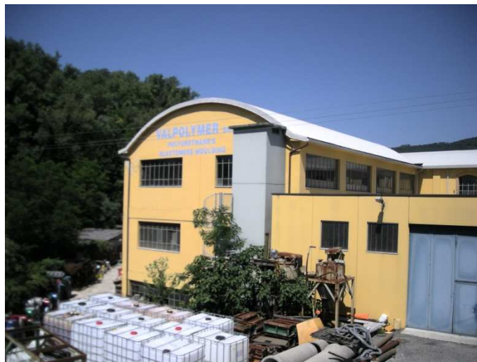
Figura 27: Storico edificio produttivo di Credaro, nato come bottonificio, oggi produce guarnizioni
