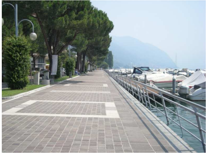
Figura 44: Il nuovo lungolago di Sarnico
