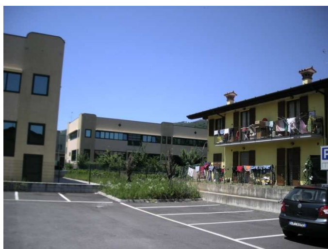
Figura 24: Nuovo complesso residenziale a ridosso dell'area industriale
