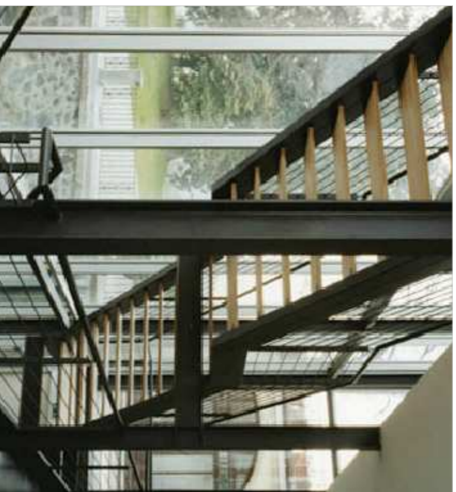
MICHELE DE LUCCHI - VILLA SCLOPIS, TORINO: tecnologia portante con profilati in ferro a vista per un intervento di carattere contemporaneo.
