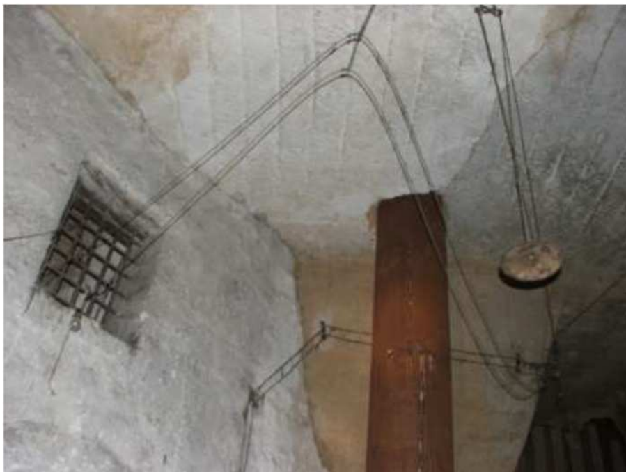
FIG. (19) – PALO INCAMICIATO CON VEDUTA PANORAMICA DELLA VOLTA (Losito, 2010)
