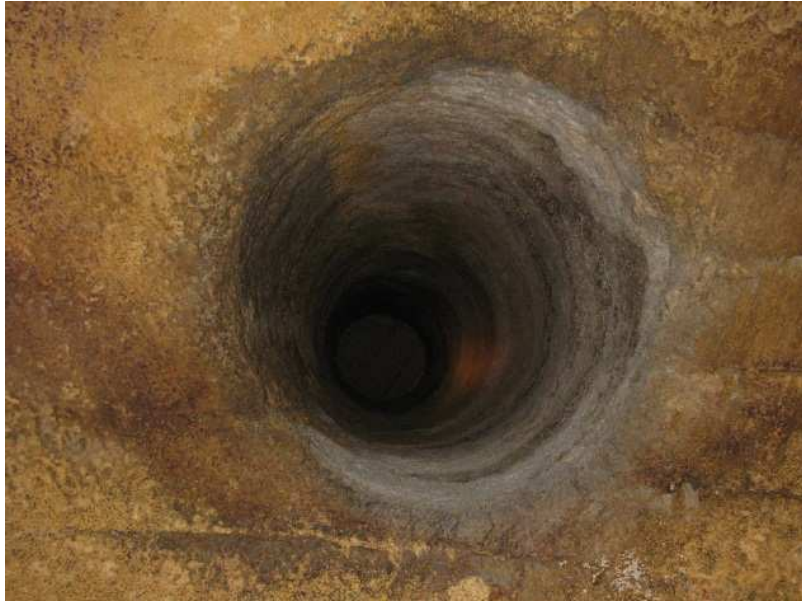
FIG. (6) – ISPEZIONE DEI LUCERNARI DAL BASSO (Di Bari, 2010)
