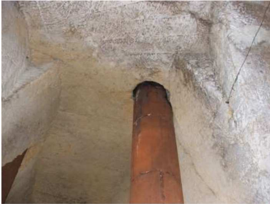
FIG. (18) – PALO INCAMICIATO – LIVELLO I (Losito, 2010)
