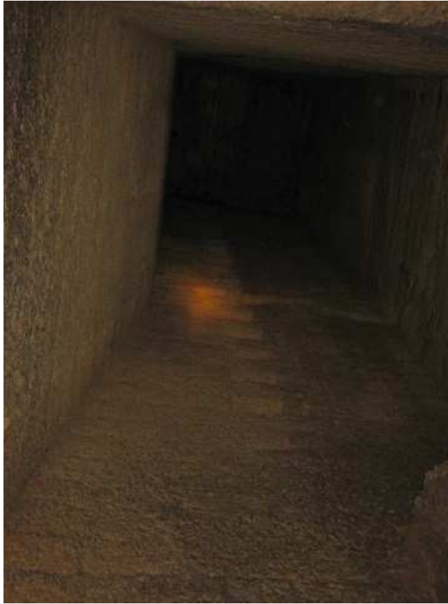
FIG. (8) – ISPEZIONE DEI LUCERNARI DAL BASSO (Di Bari, 2010)
