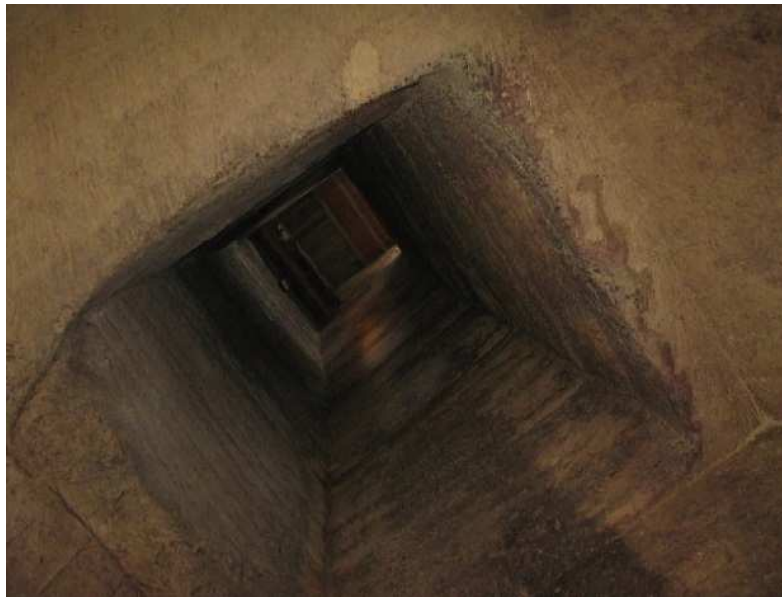
FIG. (7) – ISPEZIONE DEI LUCERNARI DAL BASSO (Di Bari, 2010)
