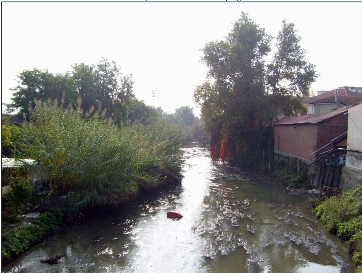
F. 77 situazione attuale del canale Cervetto, all'interno dell'area di progetto
