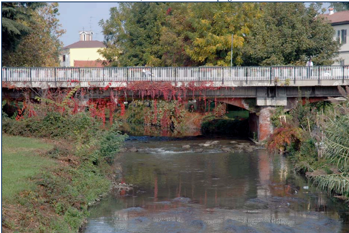
F. 78 situazione attuale del canale Cervetto, all'interno dell'area di progetto
