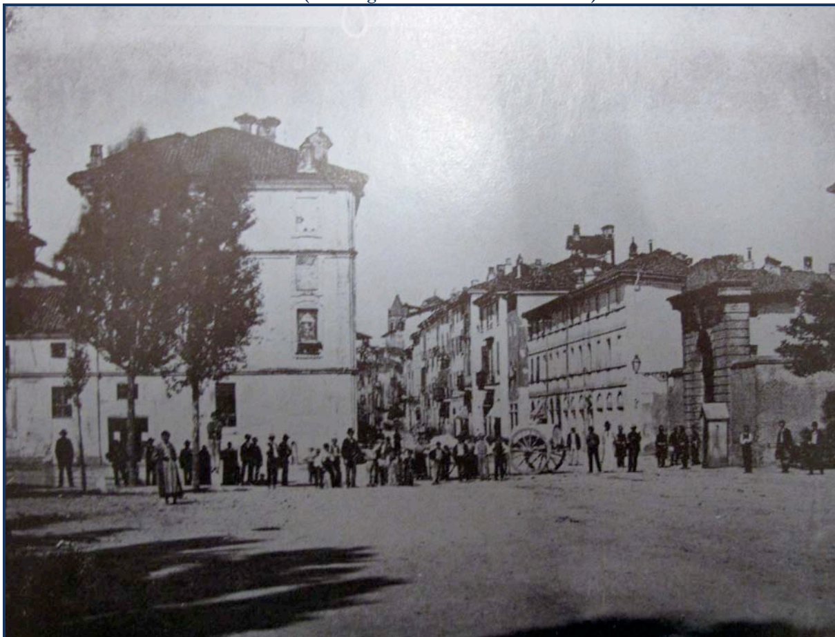
F. 15 inizio del corso da Porta Milano (con l'ingresso della vecchia caserma)
