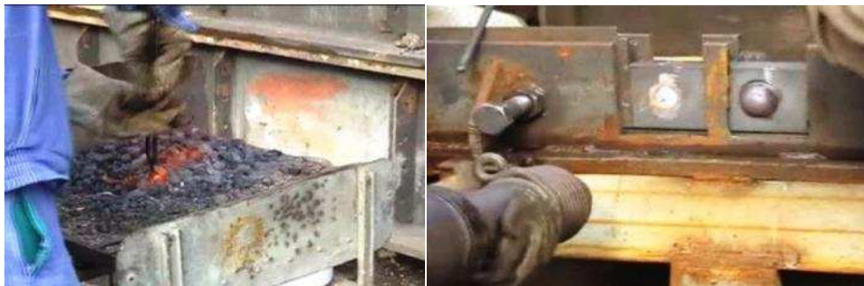
Figura 2-7: realizzazione di un'unione chiodata
