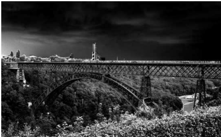
Figura 2-4: Ponte di San Michele - Ponte di Paderno d'Adda
