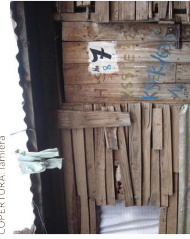
STRUTTURA: legno TAMPONAMENTO: legno COPERTURE: lamiera
