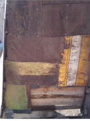
STRUTTURA: legno TAMPONAMENTO: lamiera COPERTURE: lamiera
