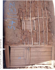
STRUTTURA: legno COPERTURE: terra COPERTURE: lamiera
