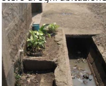
22 nuovo canale di drenaggio
