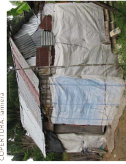
STRUTTURA: legno COPERTURE: lamiera COPERTURE: sacchi di plastica
