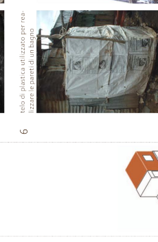
STRUTTURA: travetti di legno, irraggiamento metallico TAMPONAMENTO: sacchi di sabbia, rete metallica RIVESTIMENTO: assi di legno inchiodate alla struttura
