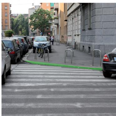
L'attraversamento di Via Buschi da Via Grossich risulta essere **sprovvisto di rampa di raccordo tra il marciapiede e la carreggiata**. Questa mancanza rende assolutamente inaccessibile il percorso per una persona con disabilità motoria.
