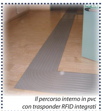
Il percorso interno in pvc con trasponder RFID integrati
