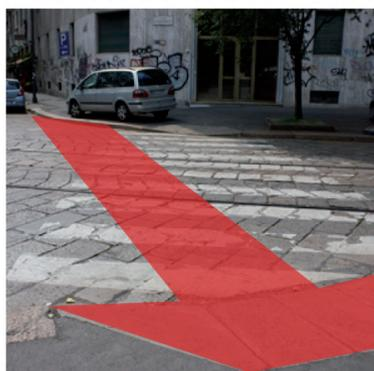
La presenza della **rampa non perpendicolare all'attraversamento** potrebbe essere fonte di pericolo per le persone con ridotta capacità visiva che vengono dirette verso il centro dell'incrocio. Oltre a questo la presenza dei binari del tram e delle **beole disconnesse della pavimentazione**, possono creare ostacolo e forme di incertezza nell'attraversamento.
