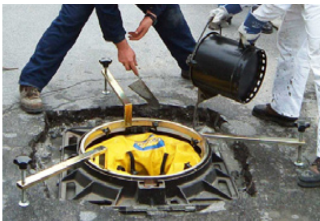
IMG 66 Dispositivo di coronamento Messa in opera
