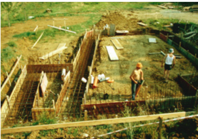
IMG 31 Posa delle fondazioni di una casa
