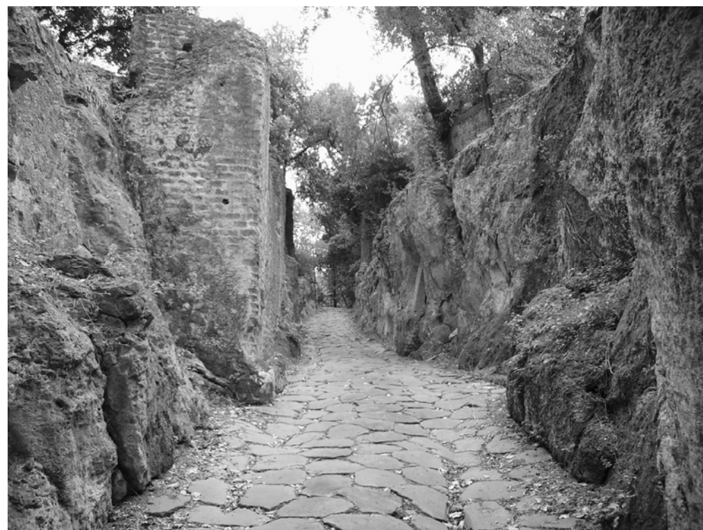
Fig. 4.1.2.3 Tratto della Via Carrabile in trincea
