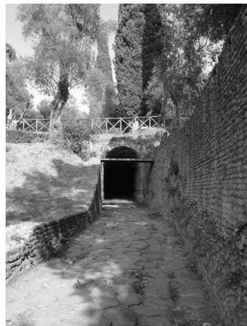
Fig. 4.1.2.1 A sinistra, Accesso al primo tratto in galleria caratterizzato dalla presenza del basolato e dalla spalla in muratura
