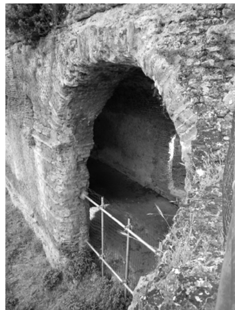
Fig. 4.1.2.11 Uscita della Via Carrabile che conduce all'Arena
