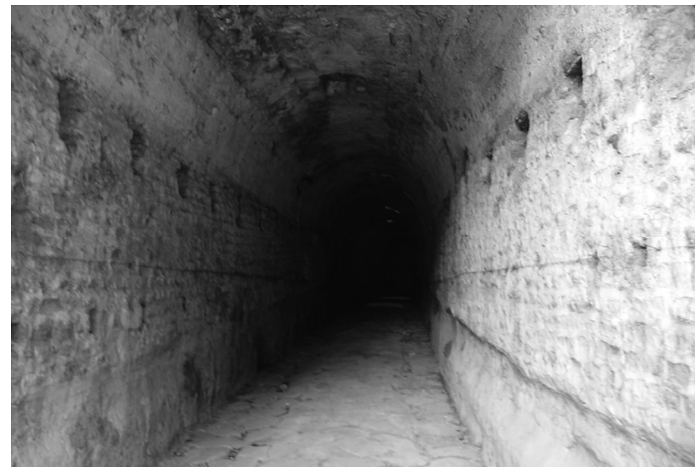
Fig. 3.3.3 La Grande Via Carrabile nel tratto ipogeo verso la Valle di Tempe.
