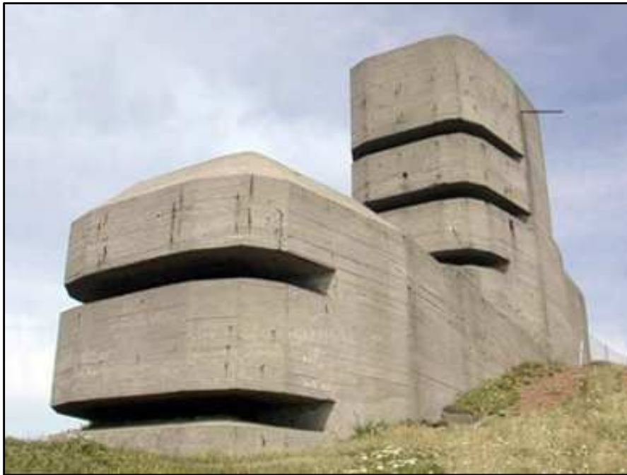
Figura 17 – Esempio di bunker di calcestruzzo
