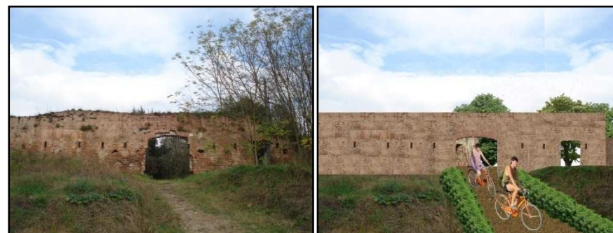
Figura 151 – Ingresso del forte: prima e dopo
