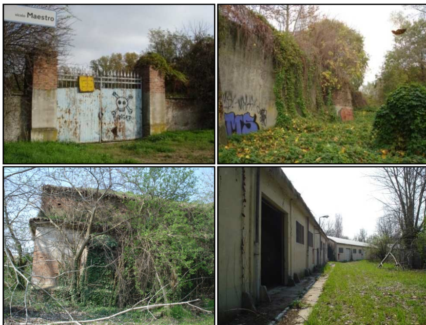
Figura 112 - Stato attuale dell'area di S. Nicolò-Gradaro
