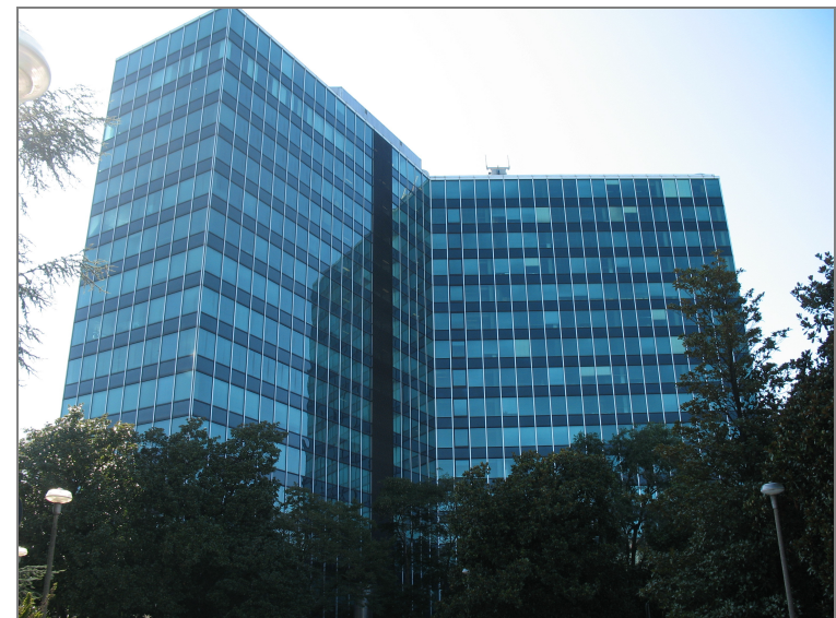
fig. 19– il PU2 visto da via guido bonarelli angolo via san salvo
