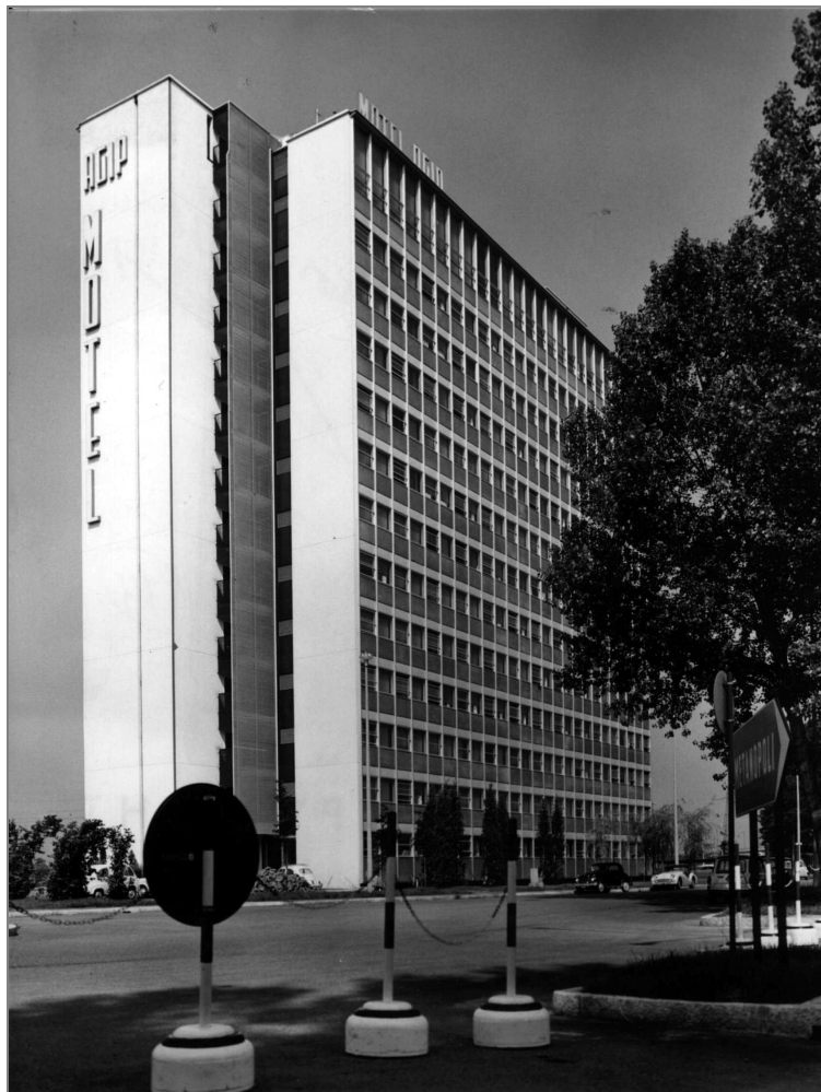
fig. 43 - corpo scala sud est (foto archivio studio alberti matti ferrari)
