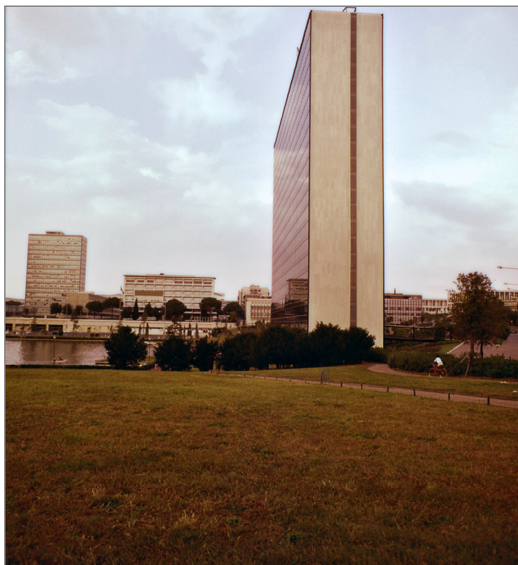
fig. 79 – il rivestimento in travertino sulle facciate minori – edificio prima dell'aggiunta delle scale antincendio (foto archivio studio alberti matti ferrari)
