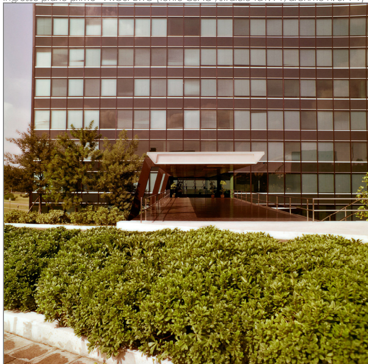
fig. 97 – la pensilina d'ingresso (foto archivio studio alberti matti ferrari)
