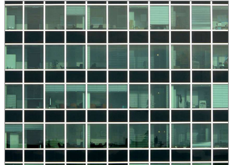
fig. 78 – la scansione modulare della facciata
