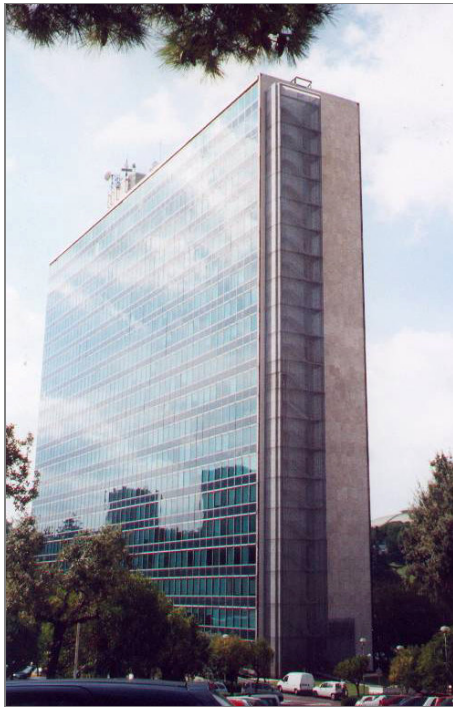
fig. 80 – l'edificio con le scale antincendio e il rivestimento in travertino sulle facciate minori
