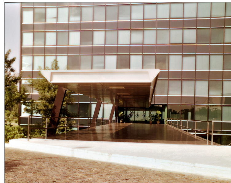
fig. 98 – la pensilina d'ingresso (foto archivio studio alberti matti ferrari)
