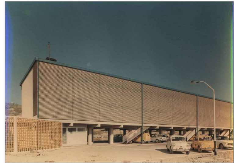
fig. 111 – i parcheggi al piano terra (archivio studio alberti matti ferrari)
