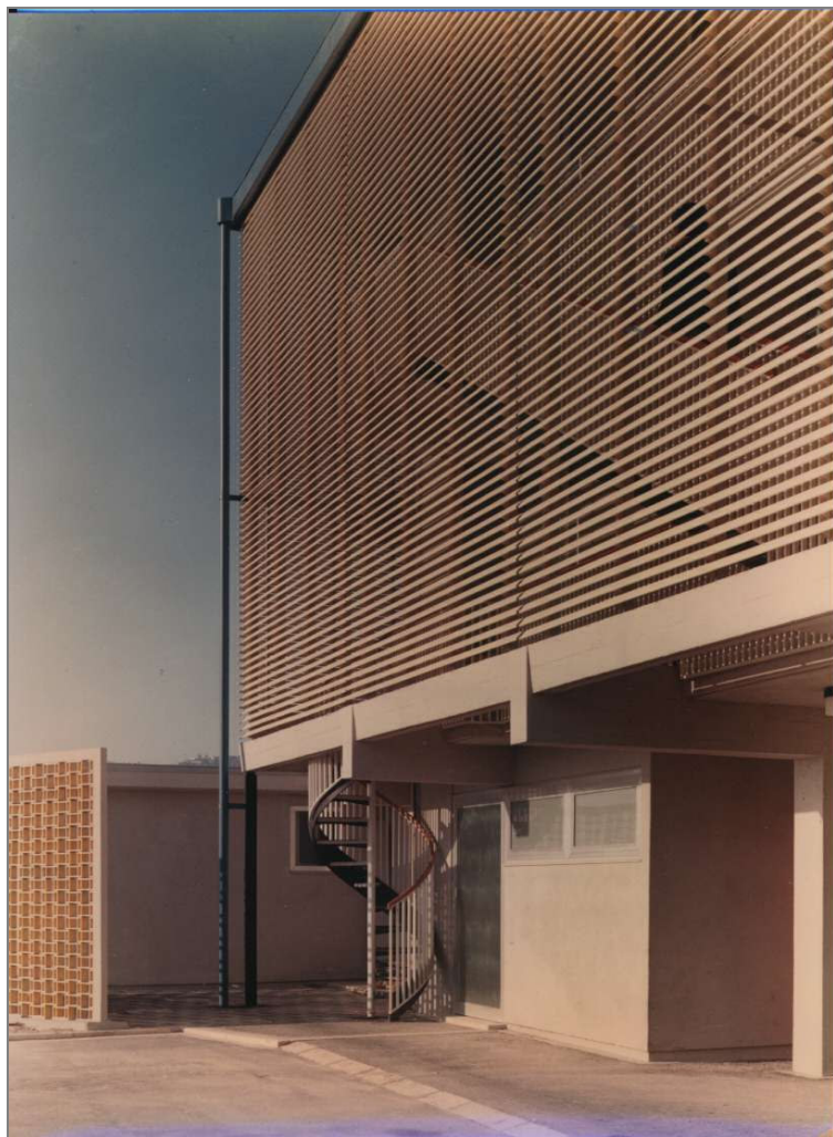
fig. 145 – la scala di servizio all'estremità sud-est (archivio studio alberti matti ferrari)
