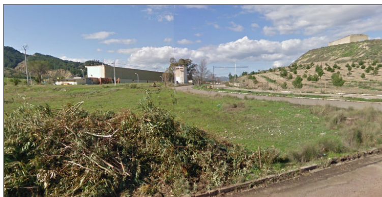
fig. 102 – il motel: veduta posteriore
