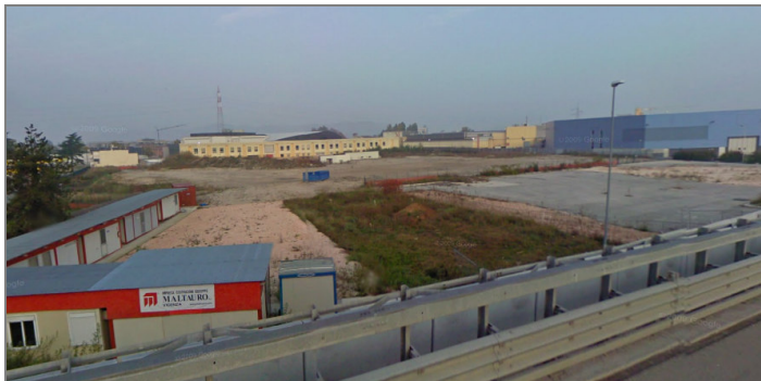
fig. 148 – l'area dopo la demolizione dell'edificio
