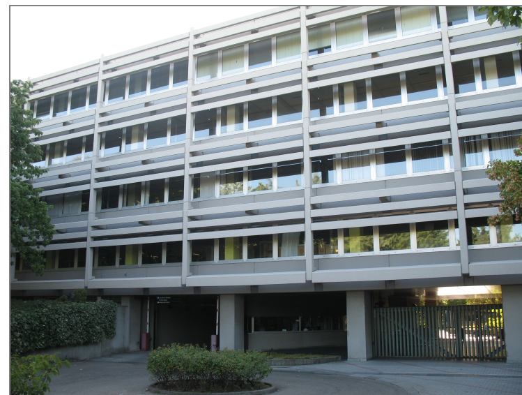
fig. 187– il PU4 visto dall'ingresso principale
