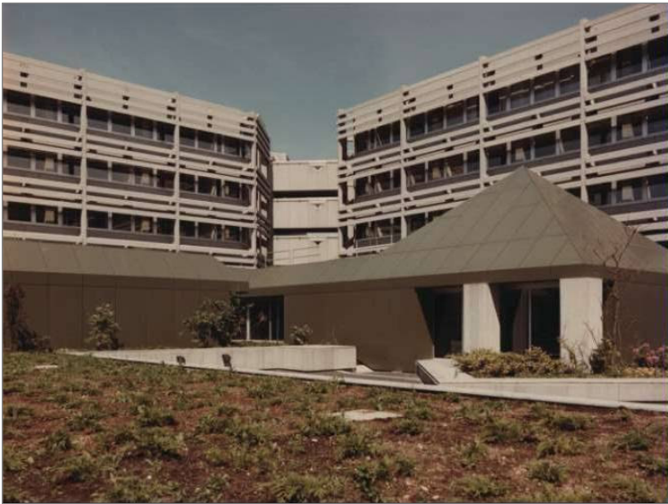
fig. 177 – il volume rivestito in pannelli di alluminio all'interno del cortile
