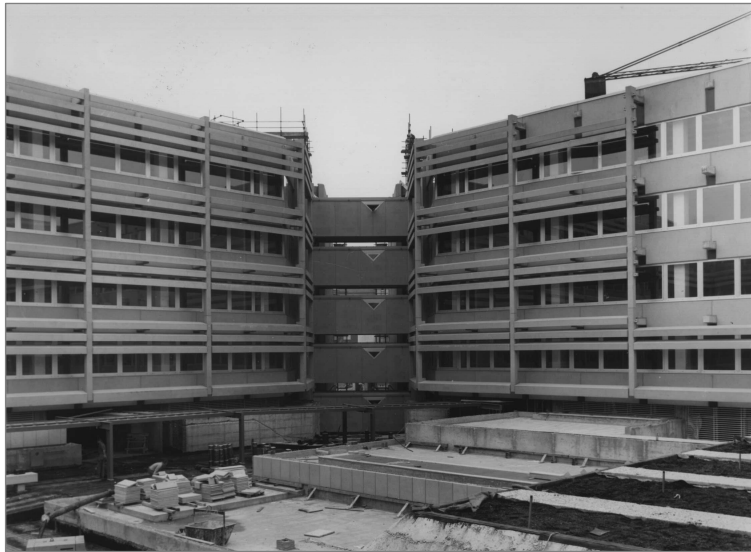
fig. 200 – la soluzione d'angolo con i collegamenti sopraelevati – A - (archivio studio alberti matti ferrari)
