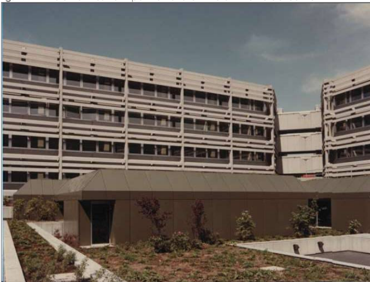
fig. 178 – il volume rivestito in pannelli di alluminio all'interno del cortile
