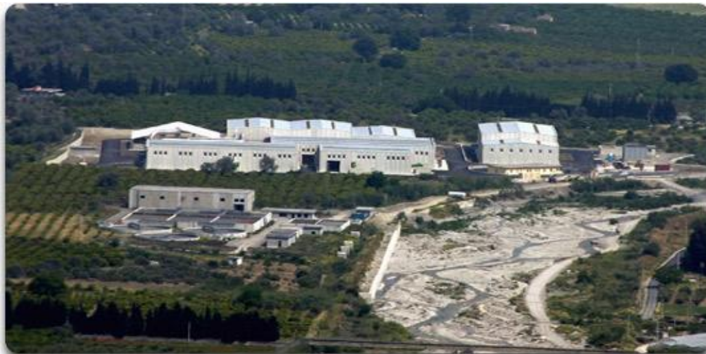
Figura 3.2 - Impianto Veolia di trattamento dei RSU di Siderno.
