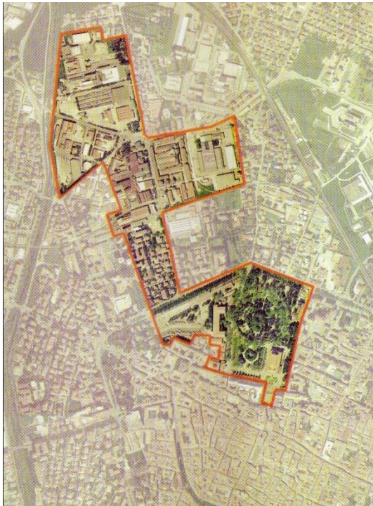
57_ area soggetta a PRU d'iniziativa di ACLI-IACP. Interessa le zone del Parco del Popolo, del quartiere Gardenia (ex aree industriali Lombardini e Consorzio Agrario Provinciale), dell'ex Foro Boario e del Macello
