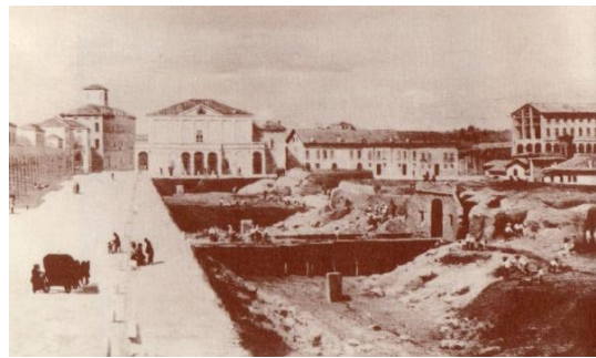
15_ demolizione della Cittadella, 1848
