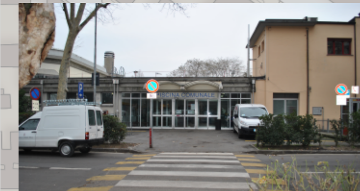
Ingresso della piscina comunale
