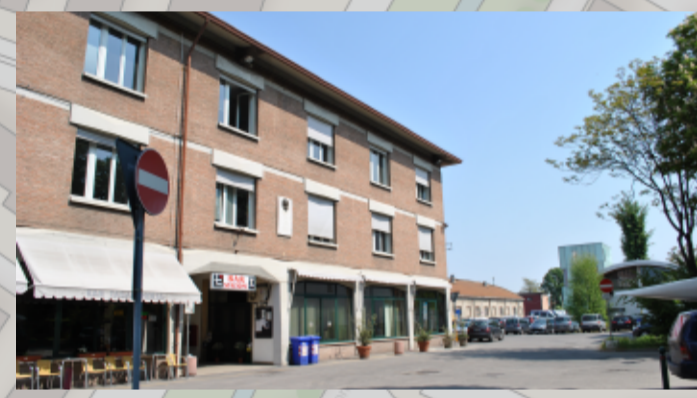
Stazione ferroviaria Santo Stefano
