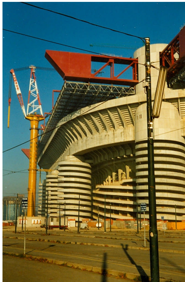
figura 1 - 6 Lavori per la costruzione del terzo anello
