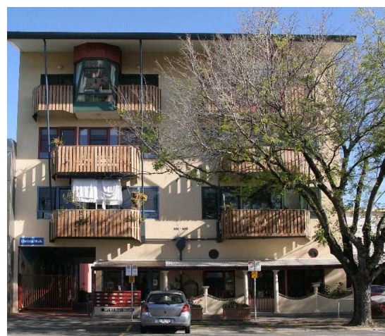
Fig.206 -Fronte principale dell'edificio di Christie Walk.
