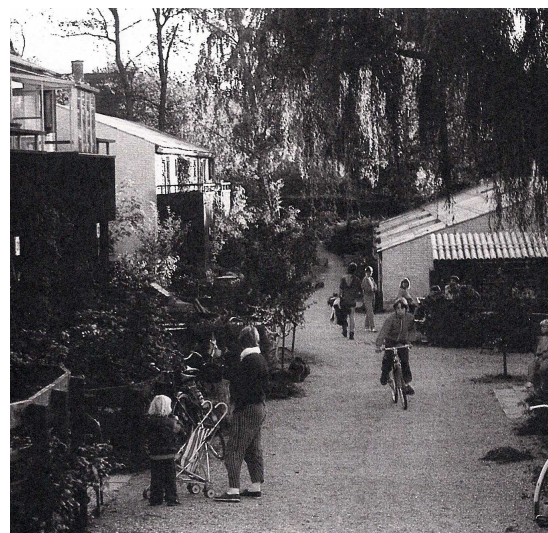
Fig.1 -Vista della strada pedonale principale, Trudslund Cohousing, Danimarca
