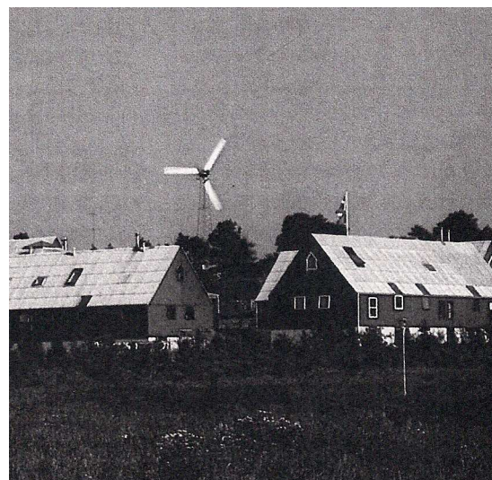
Fig.203-Particolare della turbina eolica della comunità di Sol og vind.
