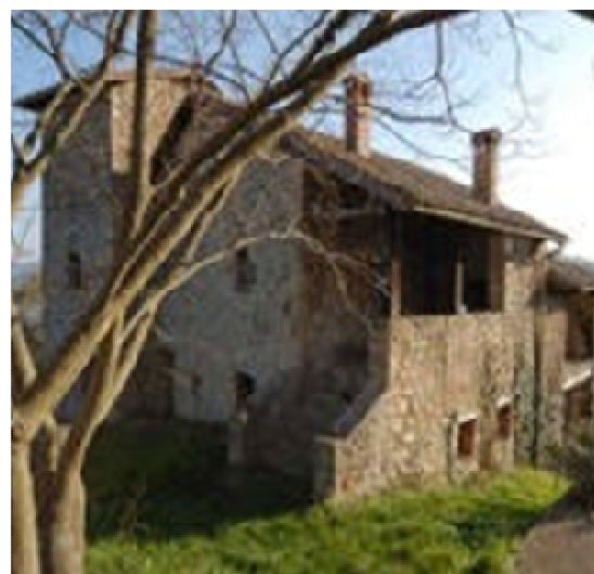
Fig.116 -Cascinale in fase di recupero per una comunità di Co-housing a Monzuno, Bologna.
