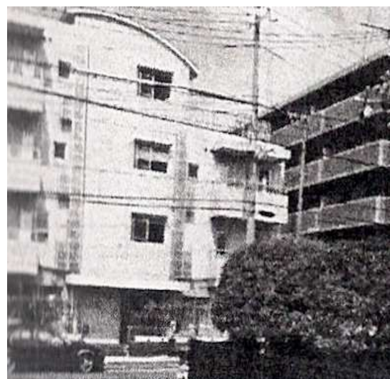
Fig.107 -Esempio di complesso per case Fureai multipiano, vista della facciata principale, Tokyo, Giappone.
