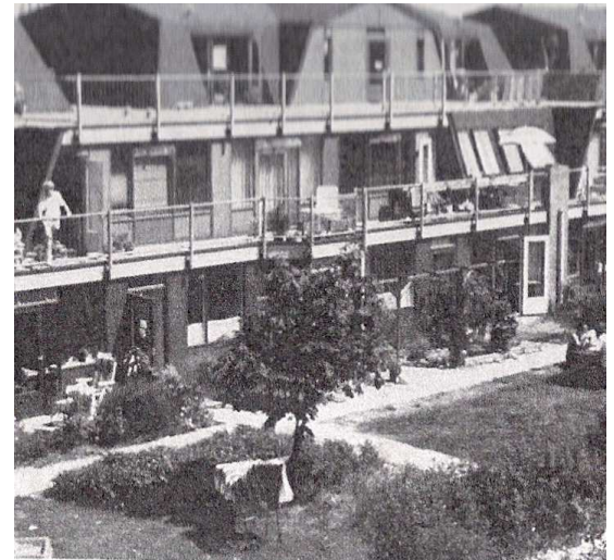
Fig.93 - Vista delle unità abitative private e del giardino comune, Purmerend Cohousing, Olanda
