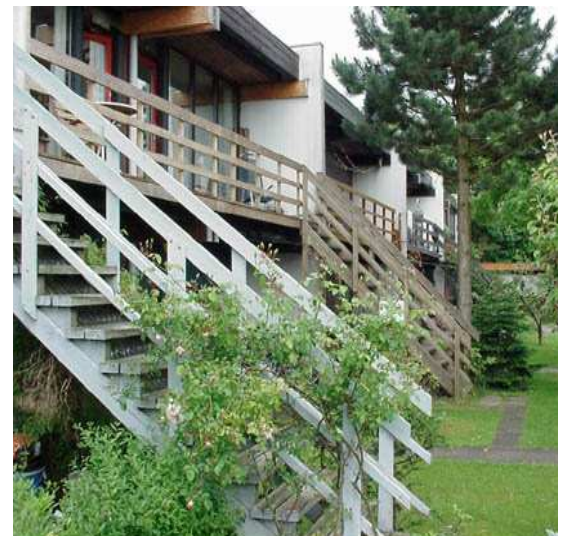
Fig.66 -Vista dell'accesso alle unità residenziali private, Saettedammen, Danimarca
