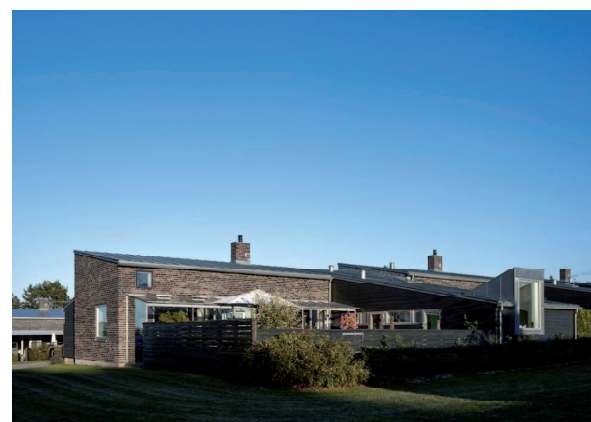
Lato sud/ovest-alloggi privati
