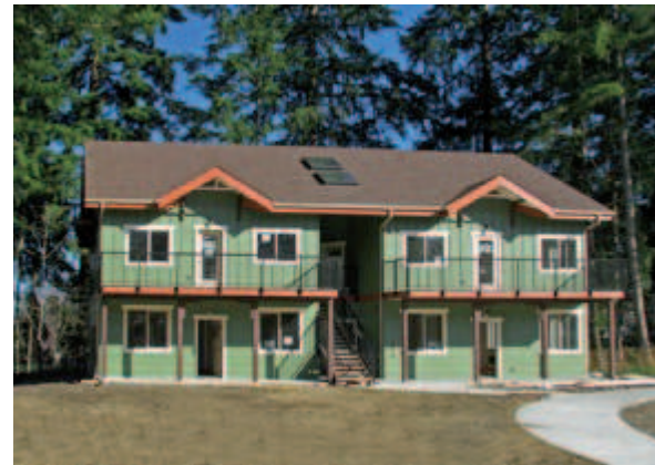
Edificio E- lato sud
