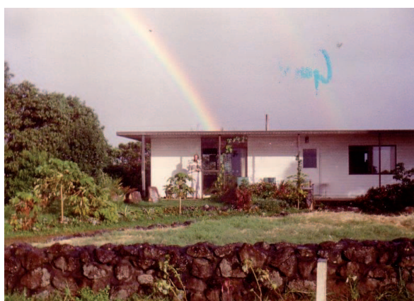
Lato sud-residenza privata
