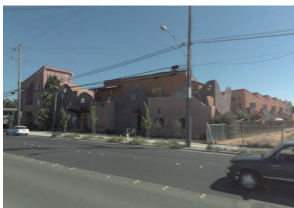
Lato sud-est - strada principale
