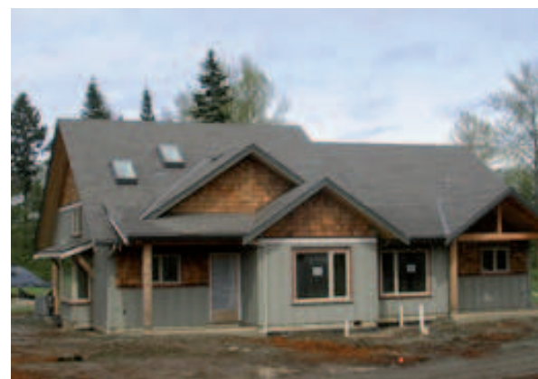
Unità residenziale-fase di costruzione
