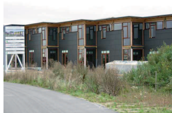
Alloggi residenziali-fase di costruzione
