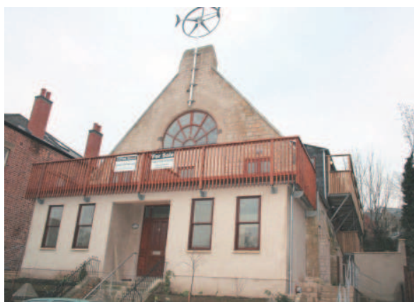
Lato sud-ingresso principale
