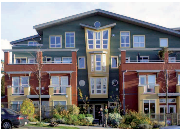
Particolare della facciata di ingresso principale
