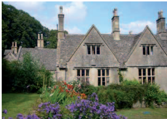
Lato ovest-residenze private
