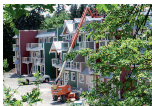
Lato nord-fase di costruzione
