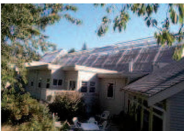
Lato est-blocco centrale esterno
