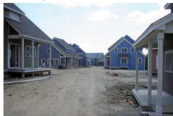
Strada pedonale-fase di costruzione
