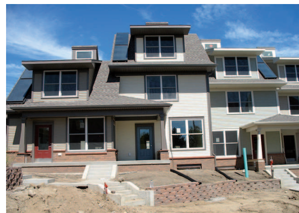
Lato sud-residenze private in costruzione
