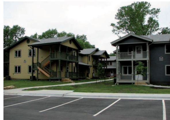
Lato est-parcheggio e unità residenziali
