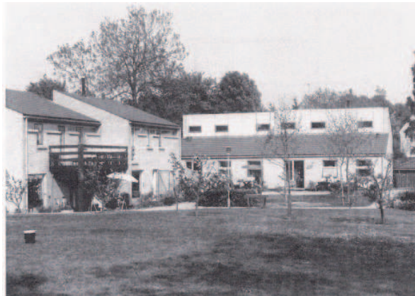
Lato ovest-giardino comune
