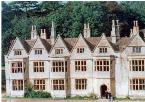
Lato sud-particolare della facciata
