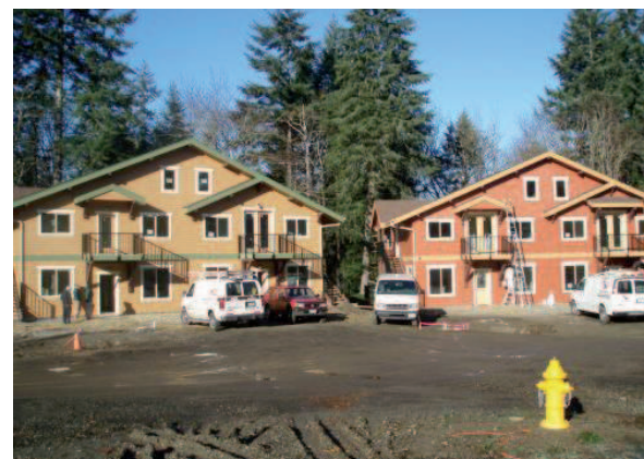
Edifici A e B in costruzione
