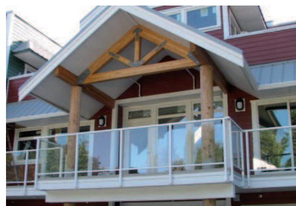
Particolare della facciata principale
