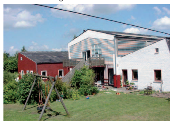
Lato sud/ovest-giardino comune
