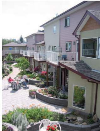
Lato sud-strada pedonale interna
