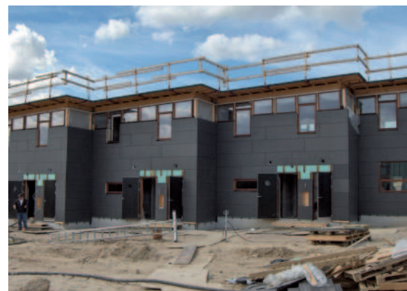
Alloggi residenziali-fase di costruzione
