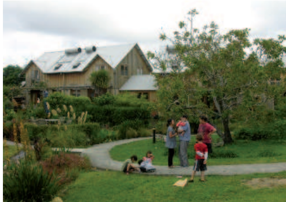
Lato ovest-giardino comune
