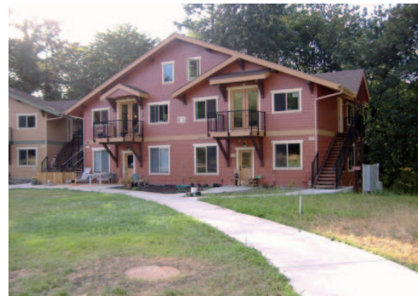
Edificio D-lato est
