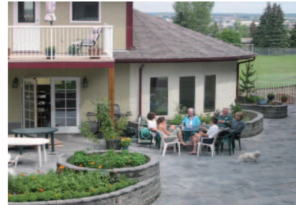
Lato sud-cortile comune
