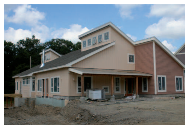
Residenza privata-fase di costruzione
