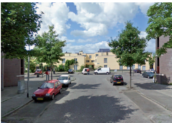
Lato sud-strada di ingresso principale
