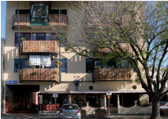
Lato sud-particolare della facciata
