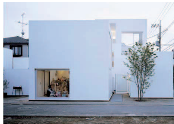
Lato sud-alloggio privato
