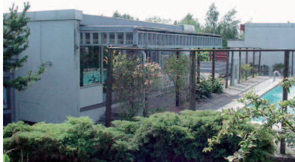
Lato nord della casa comune e della piscina
