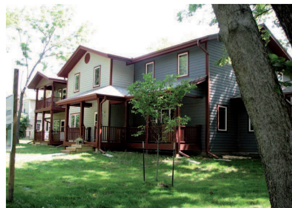
Lato sud-unità residenziali
