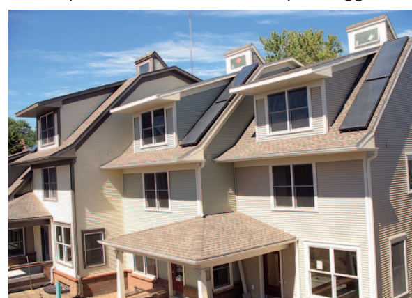
Lato ovest-residenze private
