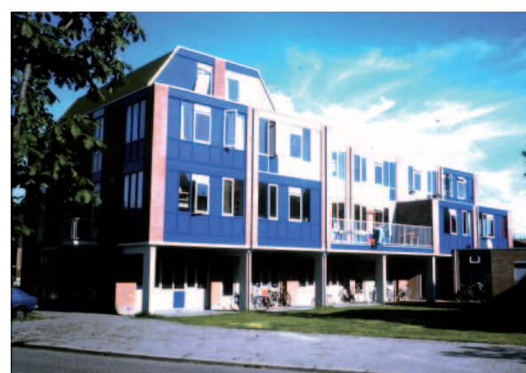
Lato sud-particolare della facciata
