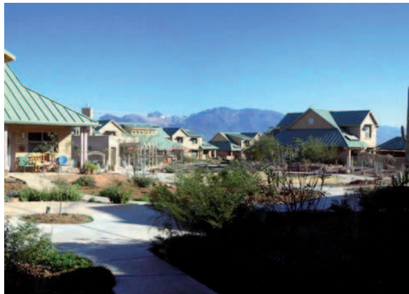
Cortile comune e Common house
