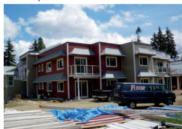
Lato nord/est-fase di costruzione
