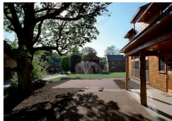
Lato sud-cortile comune
