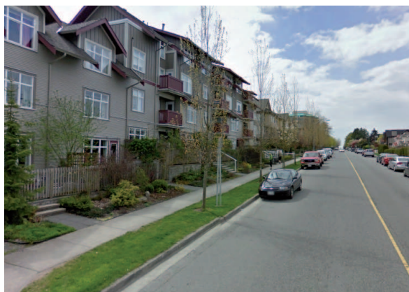
Lato ovest-strada principale
