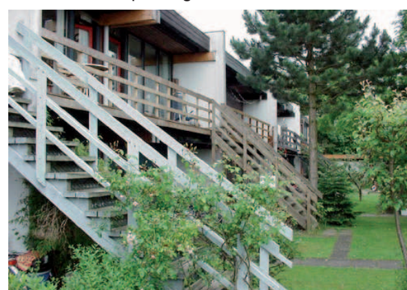
Lato sud interno-rampe di accesso agli alloggi
