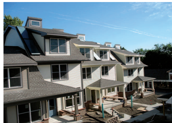
Residenze private-fase di costruzione
