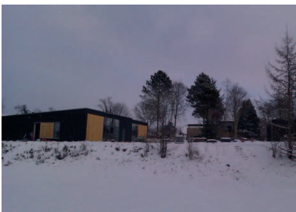
Lato sud/ovest-alloggi privati
