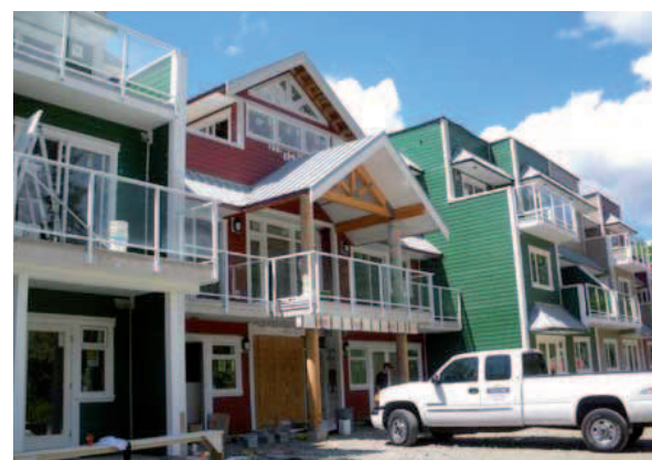
Lato sud-particolare della facciata
