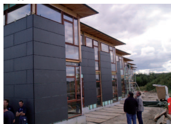
Alloggi residenziali-fase di costruzione
