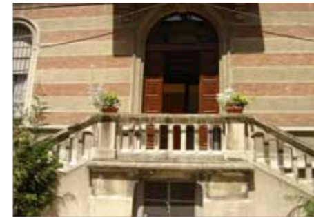
2 SCALA DI ACCESSO ALLA STRUTTURA
