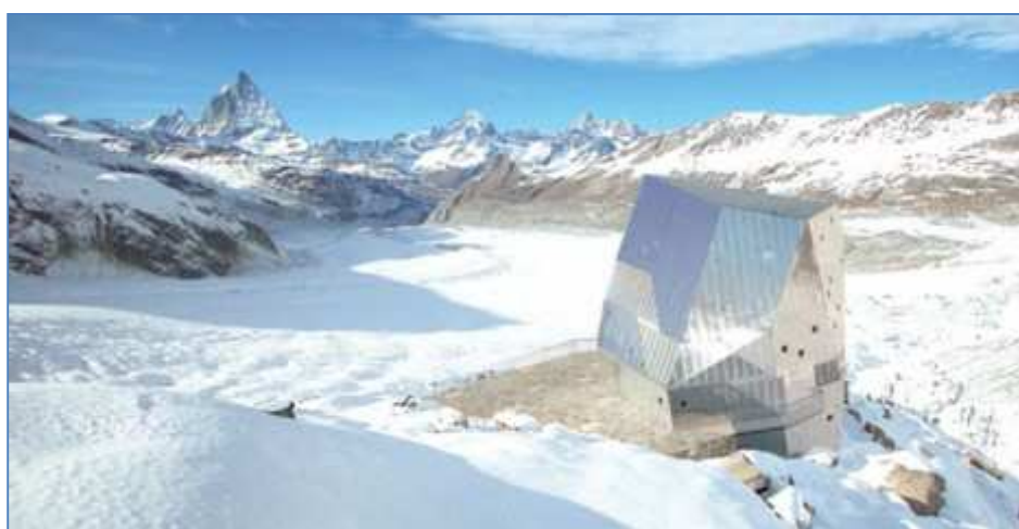
Figura 16 – Rifugio Monterosa Huetten – Zermatt 2883 m s.l.m. Fonte: Tonatiuh Ambrosetti, www.architonic.com e http://www.neuemonterosahuetten.ch
