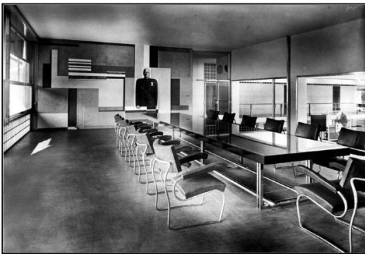
Sopra Fig.30 Casa del Fascio: particolare di una delle sale riunioni;
