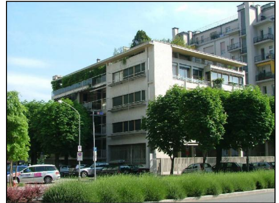
Fig.46 Immagine sopra e Fig.47, Fig.48 pagina seguente: foto dello stato attuale che evidenziano una certa corrispondenza con il progetto originale, anche i parapetti dei balconi, i serramenti e parte della recinzione è ancora quella originale.
