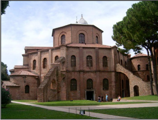
Sopra Fig.151 : vista d'insieme
