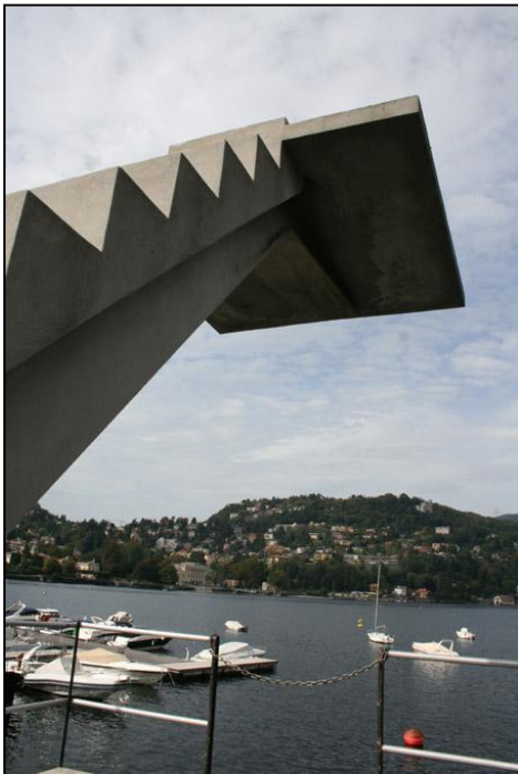
Sotto Fig.54 e Fig.55: particolare del trampolino e più in basso la sala di allenamento interna
