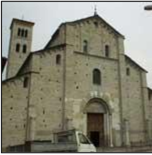
Sopra Fig.145 : facciata ovest
