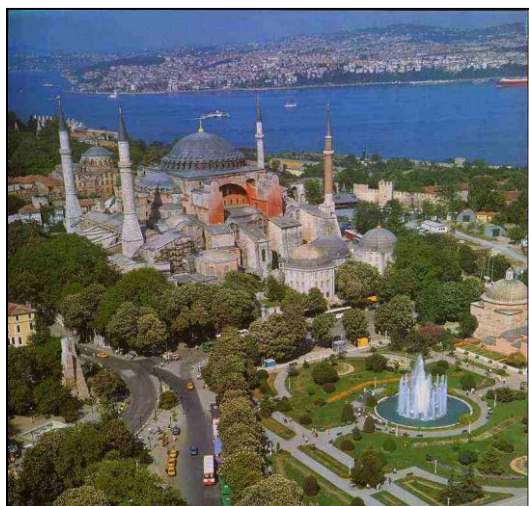
Sotto Fig.106: foto del complesso visto da ovest
