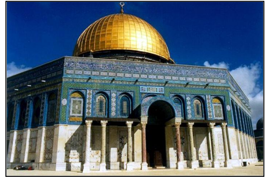
Fig.90 Ingresso alla Moschea e Cupola della Roccia. Dal XVI° secolo la decorazione policroma in maioliche vetrate di Solimano, provenienti da Matriz, sostituisce su ogni fronte il mosaico originale.
