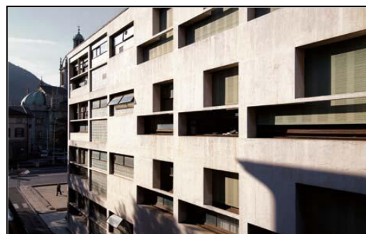
Fig.25 Casa del Fascio: facciata sud
