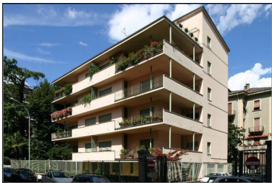
Fig.45 Vista attuale: si noti il sopralzo degli anni '50 effettuata dallo stesso Lingeri, non previsto in origine, ne altera le proporzioni d'insieme
