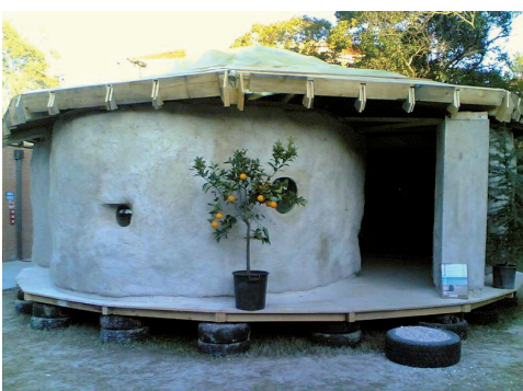
img 094, 095, 096 - Tre fasi diverse della costruzione del padiglione di paglia dello IUAV di Venezia. Fotografie tratte da www.laboa.it
