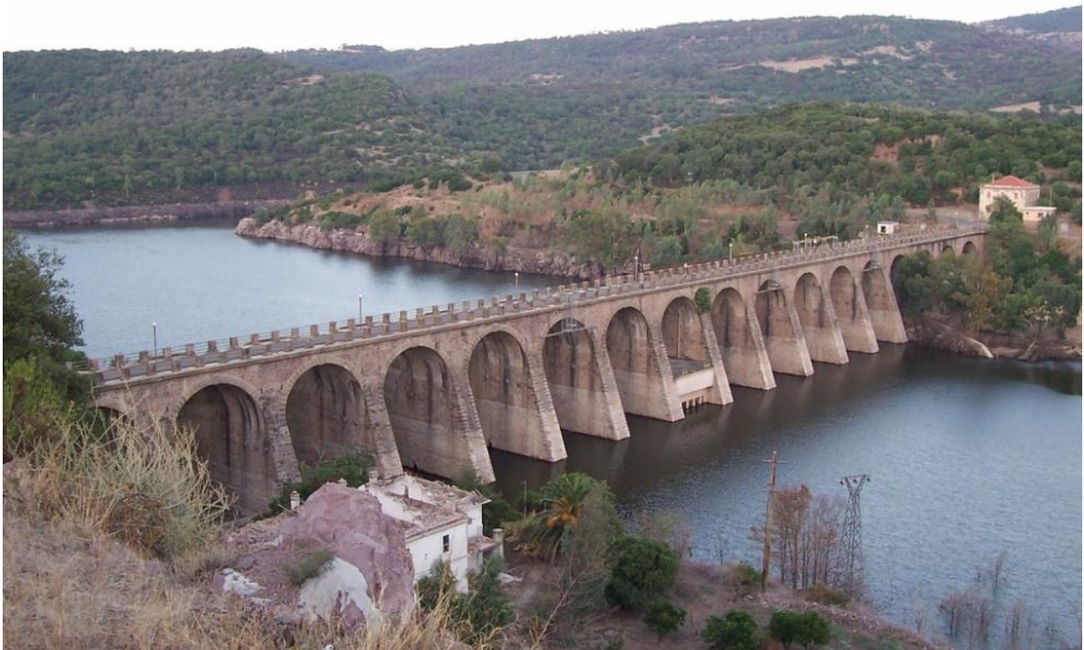
Figura 3. 2 Il paramento di valle della diga di Santa Chiara dopo la creazione delle gallerie di bypass.
