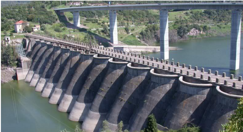
Figura 3. 1 La vecchia diga di Santa Chiara vista da monte.
