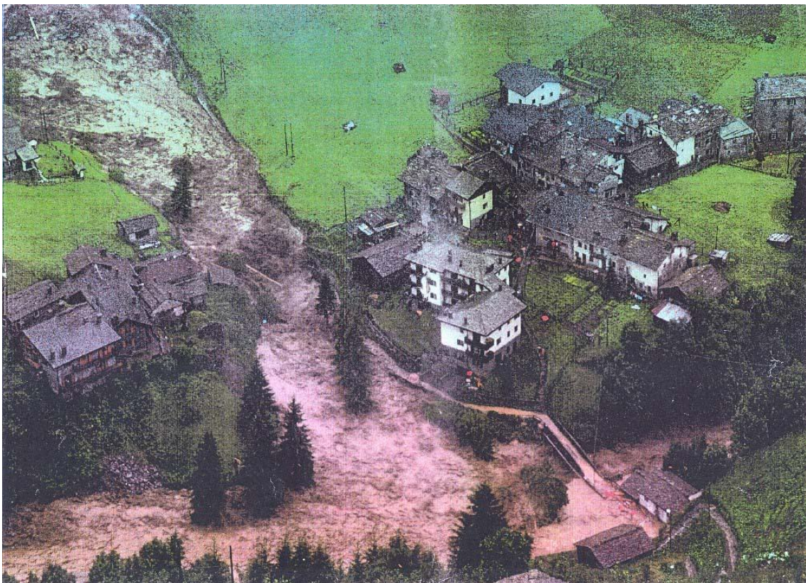
Figura 1.4 Esondazione del fiume fiume Tartano in Provincia di Sondrio, Italia 1987 [Mandelli 2006].
