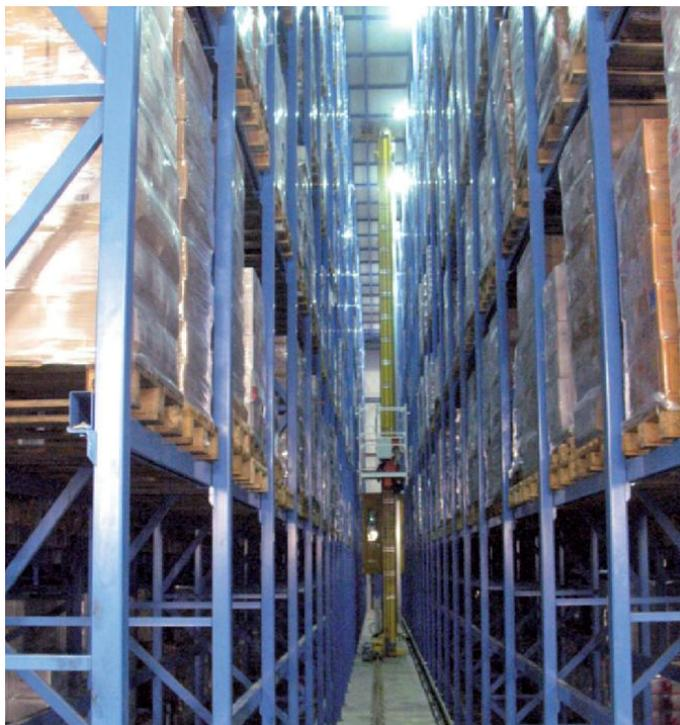
Figura 3.4 – Corridoio servito da trasloelevatore (*Polo S.p.A.*)
