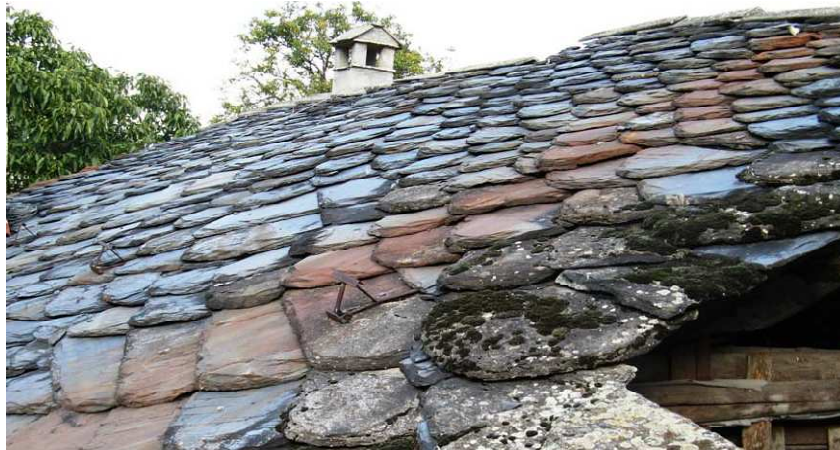
Figura 105 – Parte della falda con esposizione Ovest –
