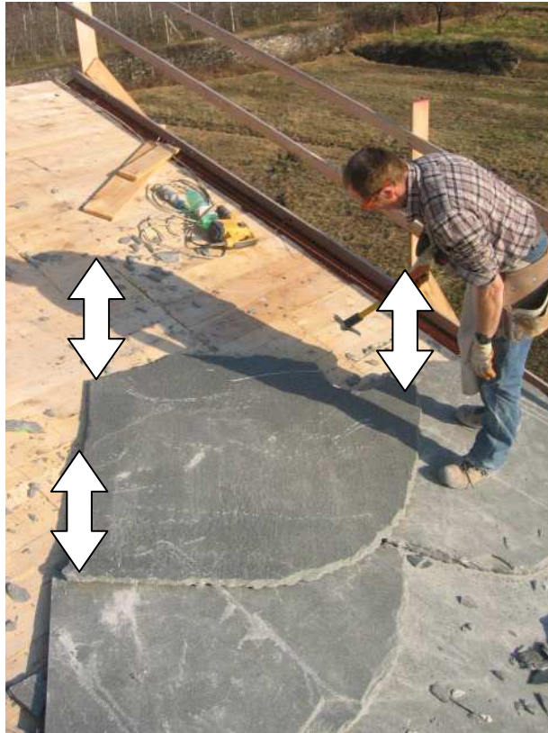
Figura 29 - Sistemazione delle scaglie nei punti di oscillazione della losa -
