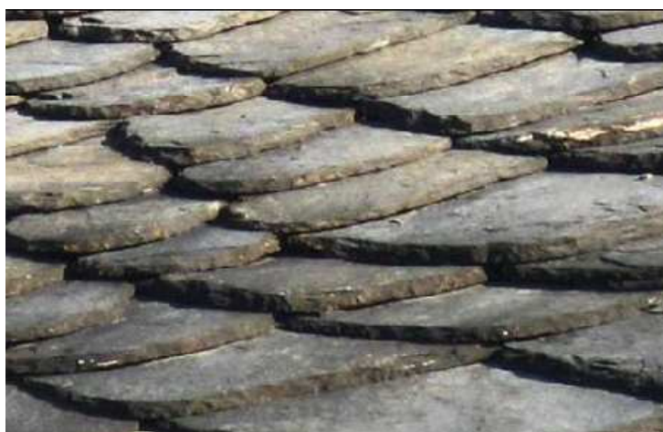
Figura 177 – Particolare della variazione di colore delle lose –
