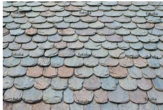
Figura 65 - Copertura in serpentino (Fonte www.fotolia.it ) –
