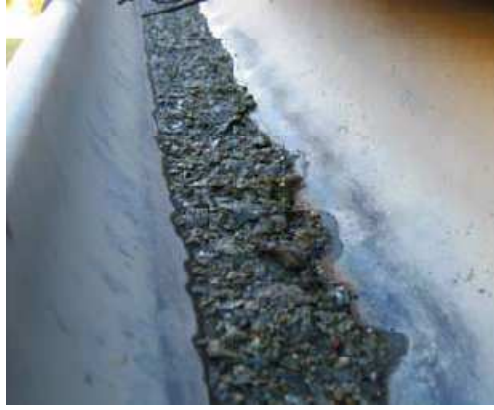
Figura 84 - Materiale depositato nel canale di gronda derivato dalla lavorazione delle lose (polveri e particolato) –
