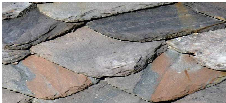
Figura 123 – Variazione del colore delle lose –
