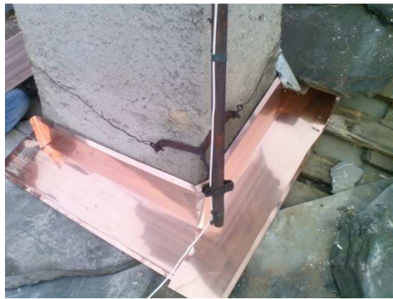
Figura 89 - Fase di posa della conca in rame intorno al camino –
