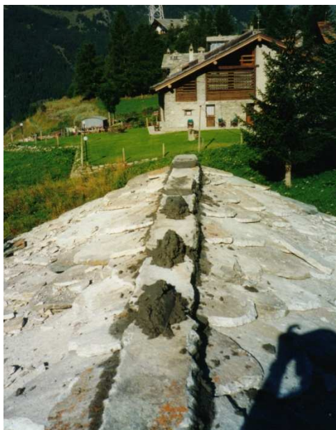
Figura 34 - Preparazione della malta per la sistemazione dei colmetti –
