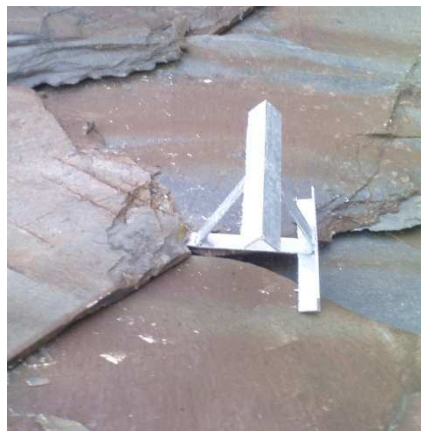
Figura 88 - Fermaneve nuovo inserito al posto del fermaneve deformato –
