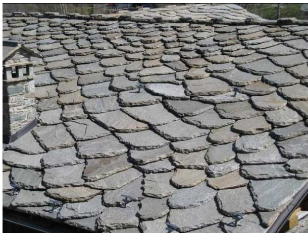
Figura 94 – Parte della falda con esposizione Nord Ovest –
