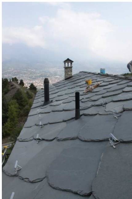
Figura 130 – Parte della falda esposta a Ovest -
