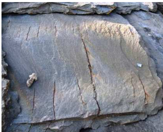
Figura 103 – Losa con intensa fessurazione –
