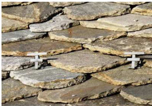
Figura 117 – Lose con colorazione tendente al giallo e segni lievi di ruggine –
