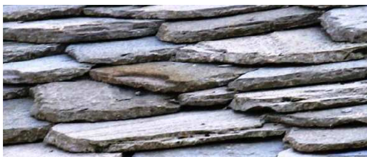
Figura 116 – Lose lievemente fratturate –
