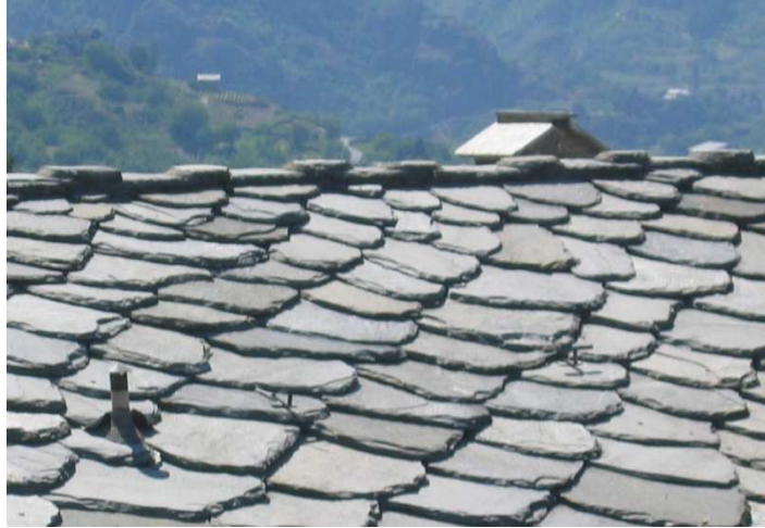
Figura 35 - Vista finale di un colmo in lose –
