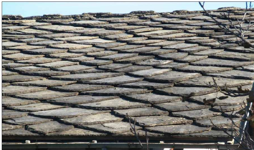
Figura 174 – Particolare della falda esposta a Ovest –
