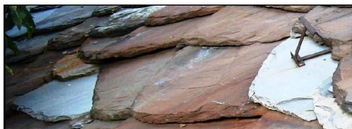
Figura 112 – Lose di calcescisto poste a sostituzione di lose fratturate –
