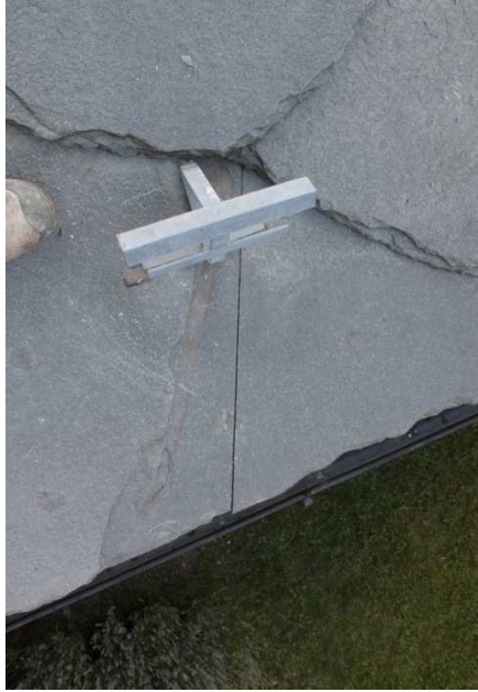
Figura 83 - Losa fratturata –
