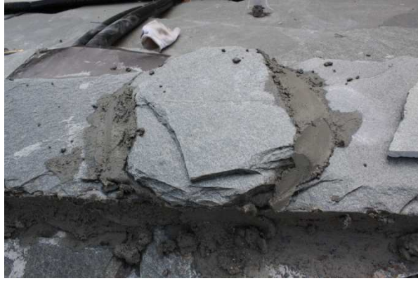
Figura 92 - Colmetto ricollocato –
