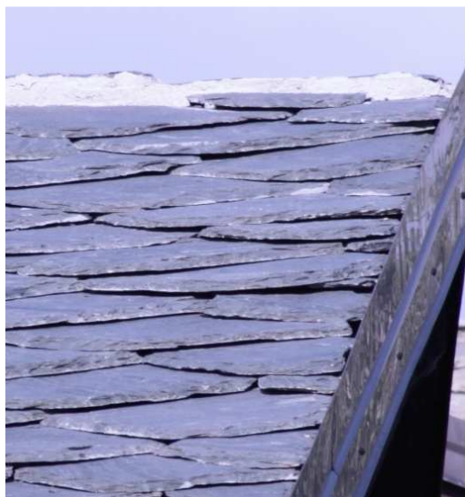
Figura 138 – Particolare rappresentante il ridotto spessore della losa nepalese –
