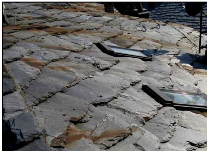
Figura 100 – Parte della falda con esposizione Ovest –
