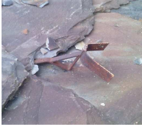
Figura 87 - Fermaneve schiacciato e deformato dal peso del manto nevoso invernale –
