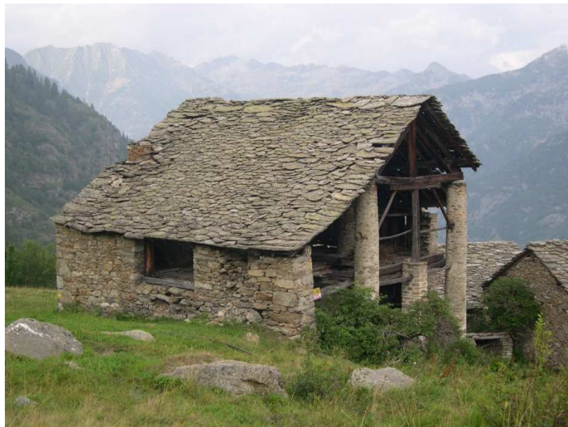
Figura 50 – Copertura antica nel comune di Issime -
