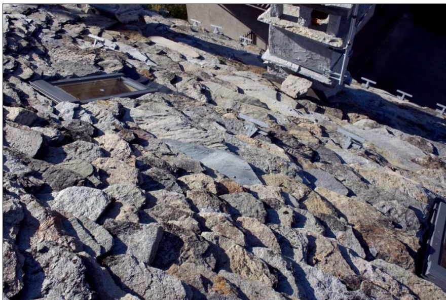
Figura 160 – Parte di falda esposta a Ovest –
