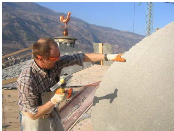
Figura 27 - Fase di lavorazione di una losa –
