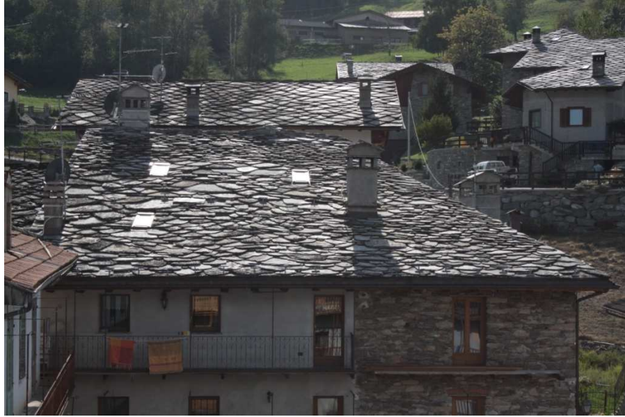
Figura 49 – Copertura recente realizzata con lose di recupero seguendo la tecnica antica –
