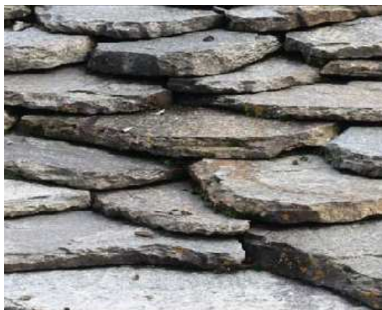
Figura 96 – Lose con presenza di piccoli muschi e licheni –
