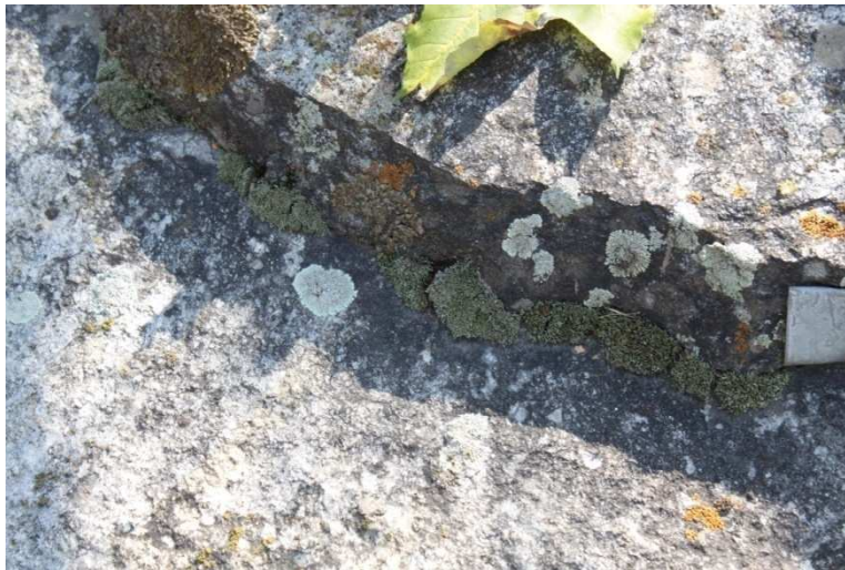
Figura 142 – Muschi e licheni presenti sul bordo inferiore di molte losse della falda esposta a Nord –
