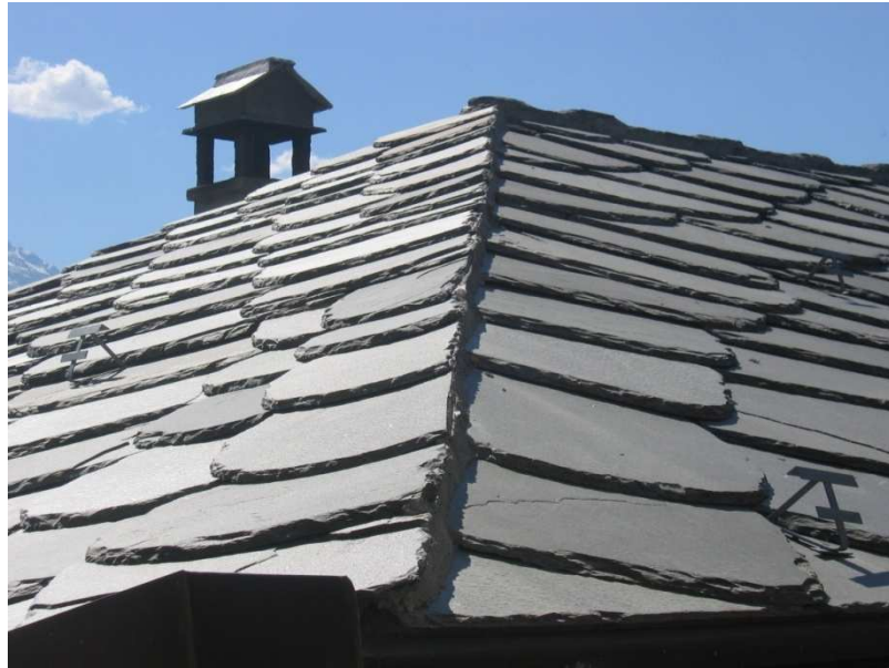
Figura 43 – Giunzione di due falde ortogonali con sovrapposizione lose –
