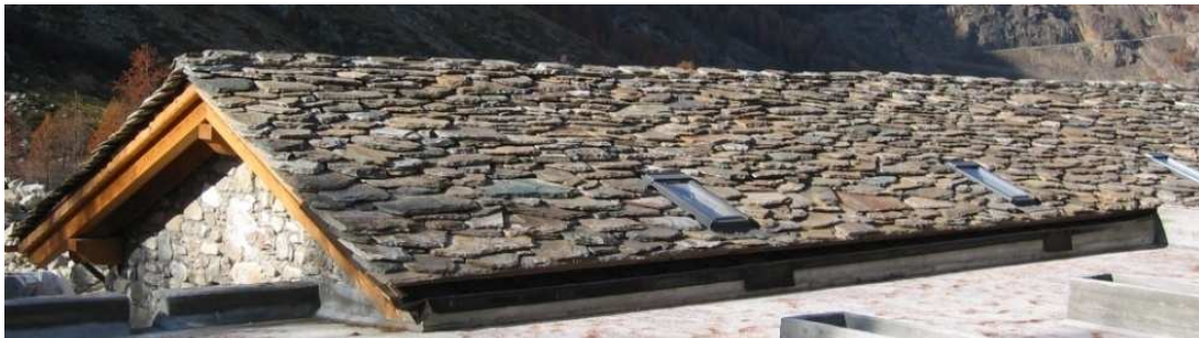
Figura 48 - Copertura recente realizzata con lose di recupero seguendo la tecnica antica –
