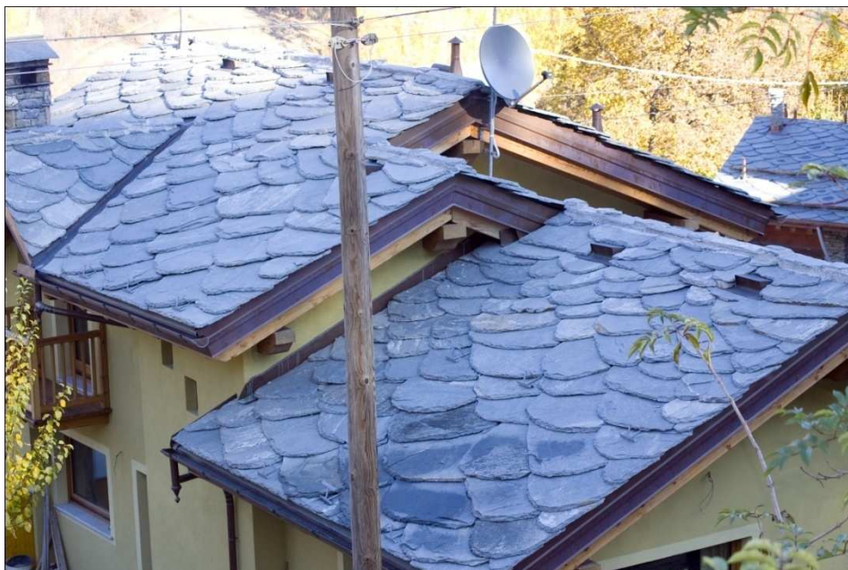
Figura 156 – Parte della falda esposta a Ovest –
