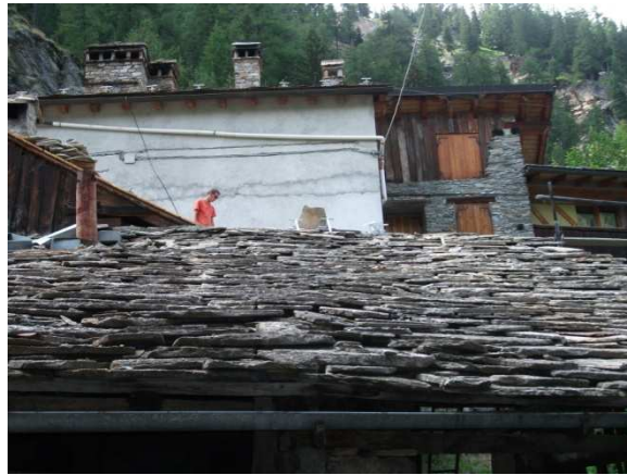
Figura 73 – Copertura da cui sono stati ricavati i provini di losa testati –
