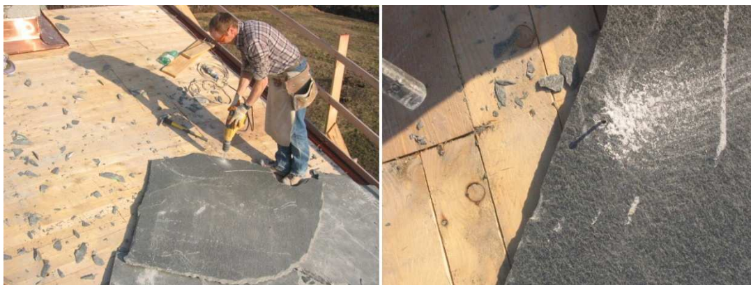
Figura 30 - Fase di foratura e di inchiodatura della losa -
