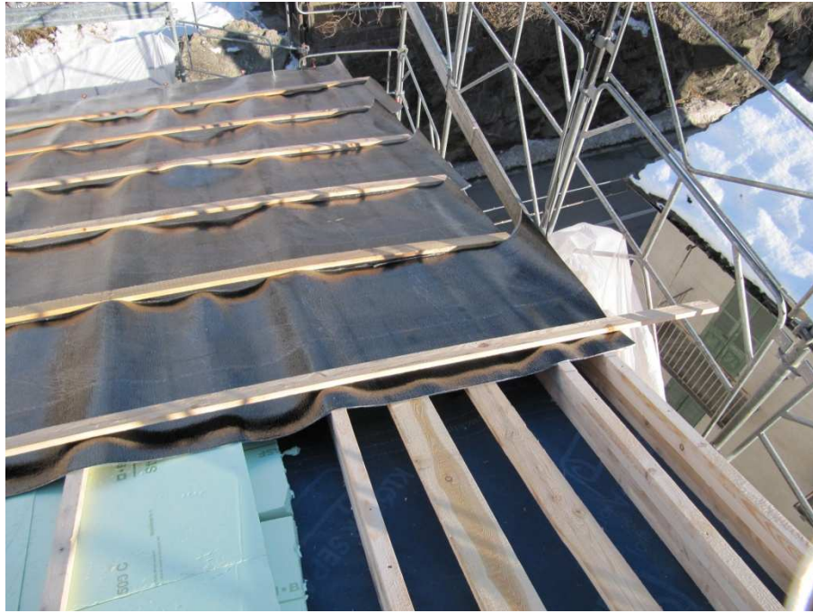
Figura 18 – Strati della copertura: barriera vapore, isolante e guaina elastomerica -
