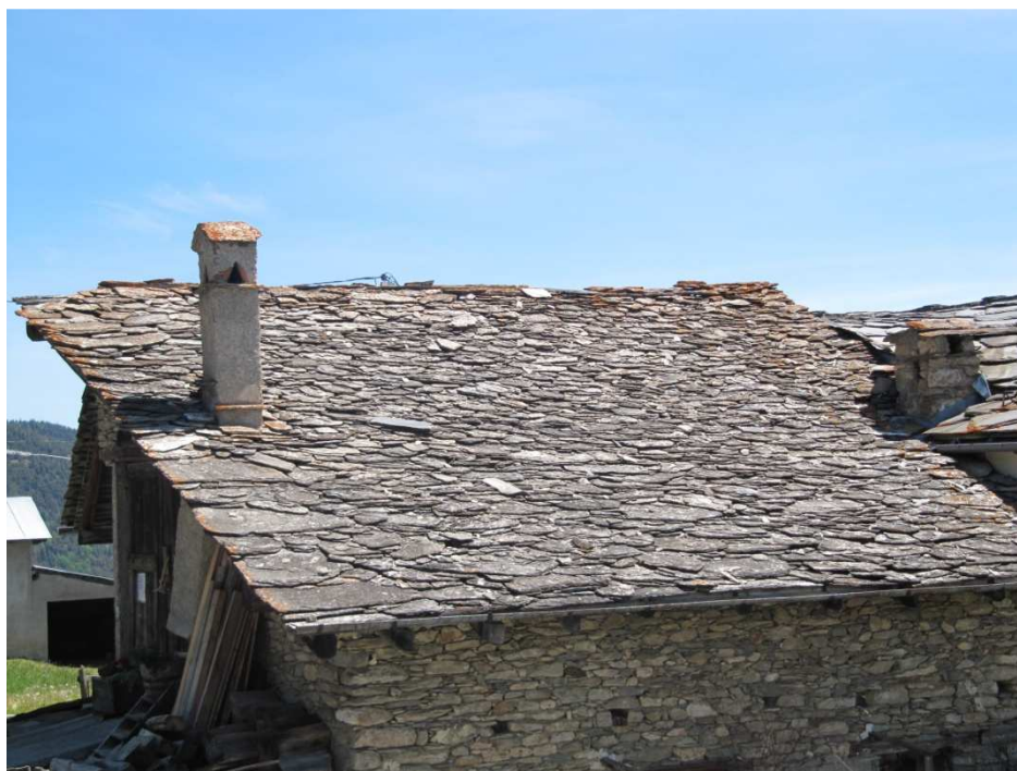
Figura 1 - Edificio risalente alla fine del XIX secolo situato in Fraz. Vetan, Saint Pierre, Valle d'Aosta -
