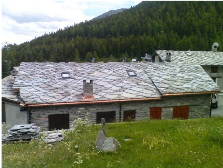
Figura 75 – Manto in lose, ricostruito con il materiale in questione, da cui sono state presi i campioni di losa di Morgex –
