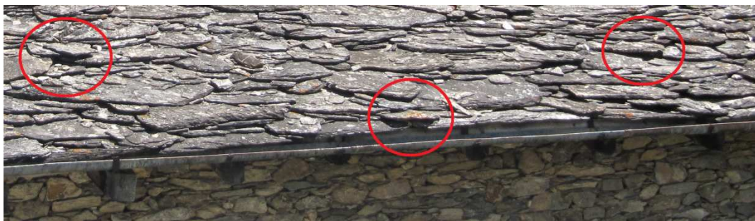
Figura 77 - Lose uscite dalla loro sede originale –
