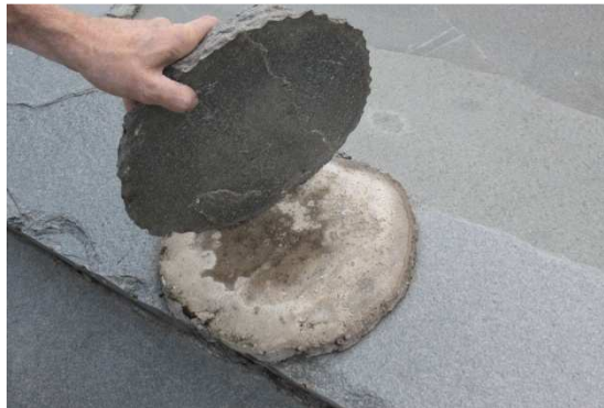
Figura 91 - Colmetto distaccato dalla base in cemento –
