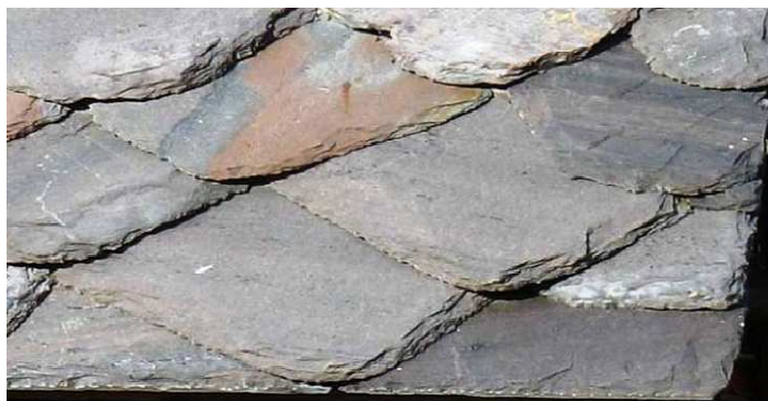
Figura 125 – Lose in buono stato di conservazione –
