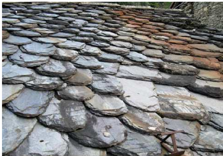
Figura 106 – Parte della falda con esposizione Ovest –
