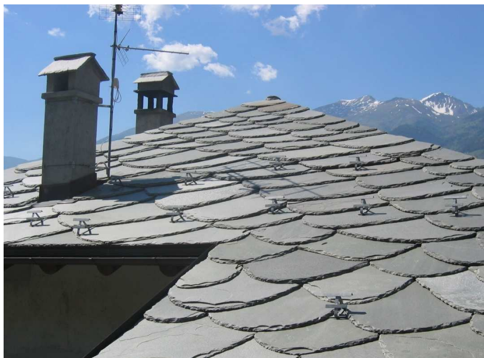
Figura 24 - Copertura recente in lose lavorate a goccia situata nel comune di Aymavilles -
