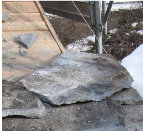
Figura 37 – Sporto della losa dal bordo del tetto di circa 10 cm –
