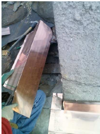
Figura 90 - Fase di modellazione manuale della conca –
