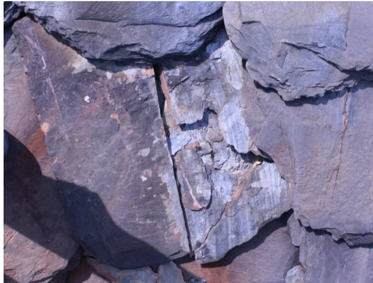
Figura 147 – Losa originante ruggine e marcita nel tempo –
