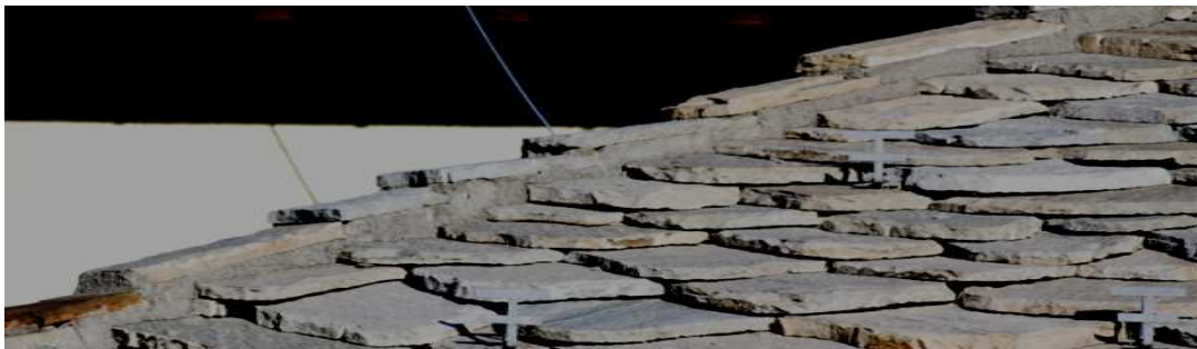
Figura 38 – Colmo obliquo utilizzato per congiungere due falde ortogonali tra loro –
