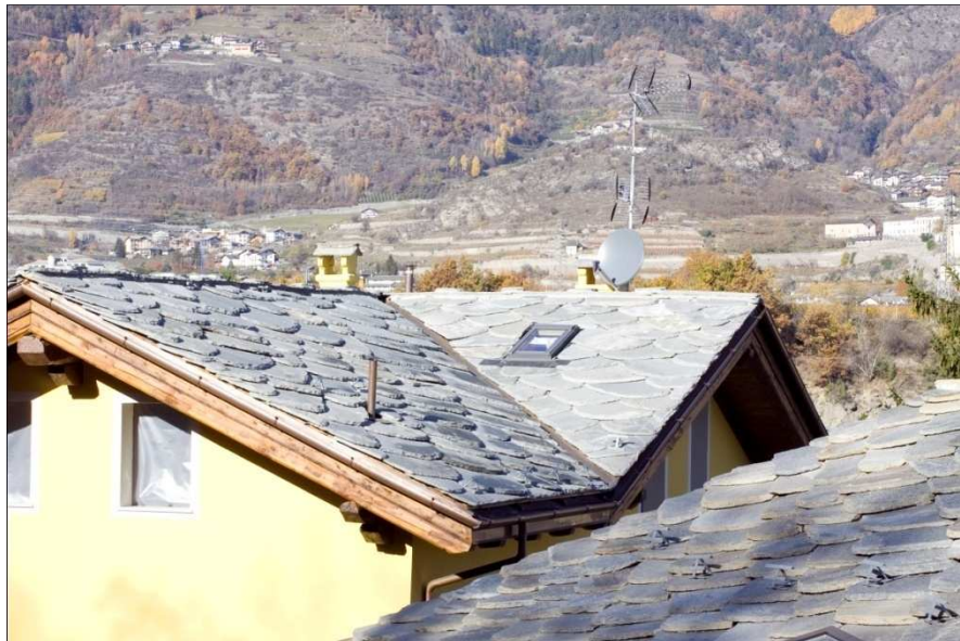
Figura 171 – Parte della falda esposta a Nord-Est –
