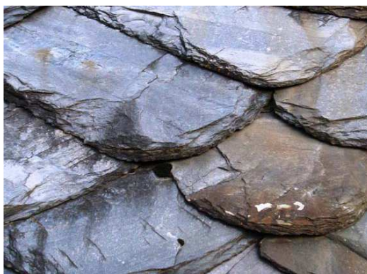
Figura 107 – Lose di porfiroide posate nel 1982 –
