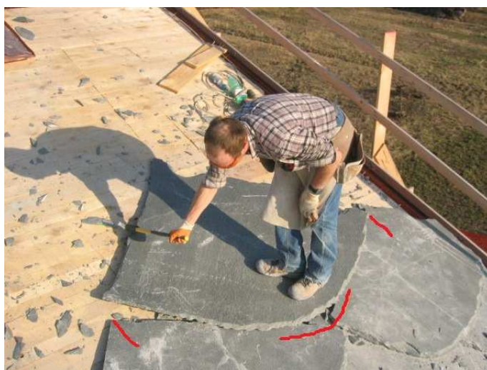
Figura 28 - Fase di posa della losa con bordi segnati in precedenza con del mattone evidenziati in rosso –
