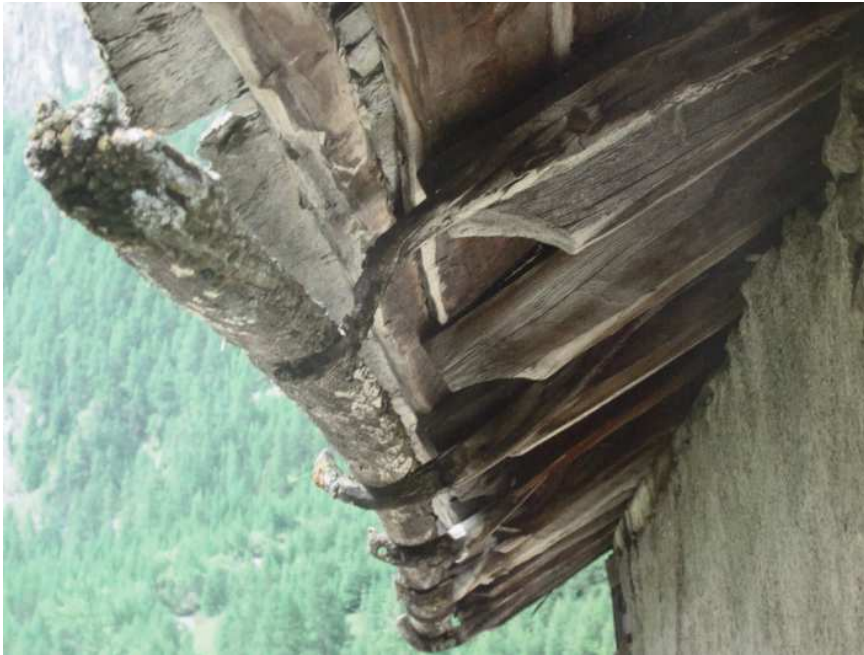
Figura 10 – Canale di gronda e cigogne in legno –
