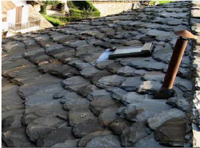
Figura 99 – Parte della falda con esposizione Est –
