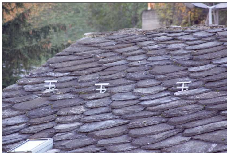
Figura 154 – Presenza di muschi e licheni sulla falda esposta a Nord e colorazione delle lose tendente al grigio scuro –
