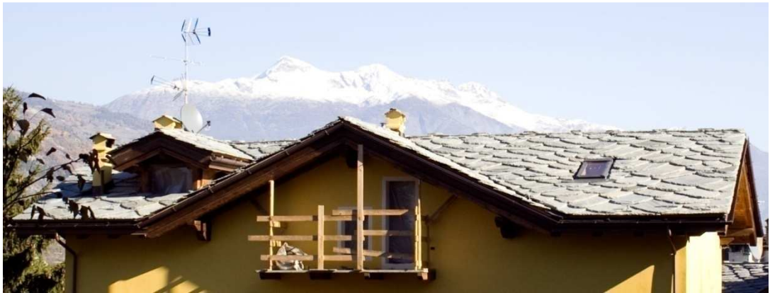
Figura 170 – Parte della falda esposta a Sud-Ovest –
