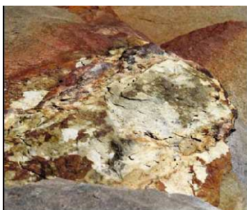
Figura 102 – Losa con nodo da cui si origina la ruggine –
