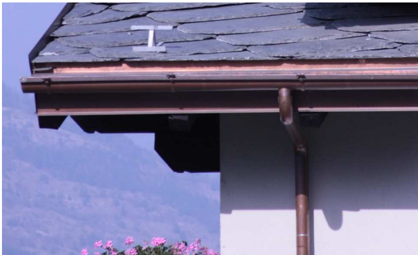
Figura 86 - Canale di gronda e pluviale in rame –
