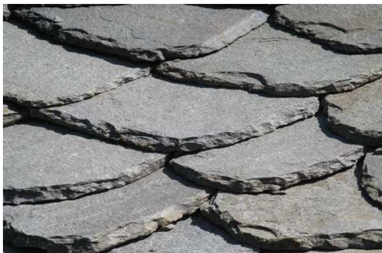
Figura 97 – Lose in ottimo stato di conservazione e presenza di piccoli detriti di lavorazione –
