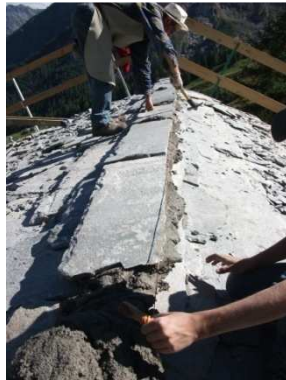
Figura 32 - Controllo della rettilineità della linea di colmo -
