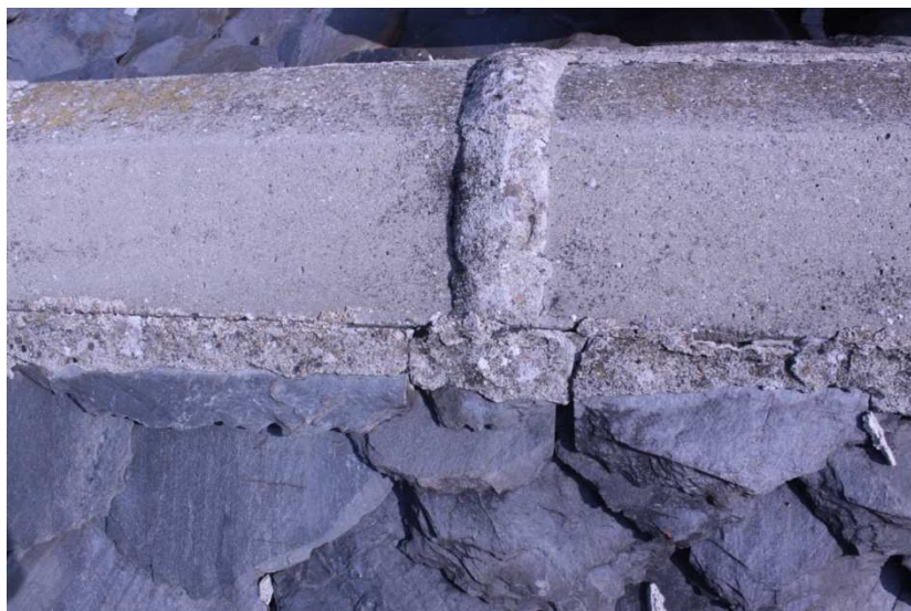
Figura 149 – Colmo in cemento prefabbricato tipicamente utilizzato negli anni di realizzazione della copertura –
