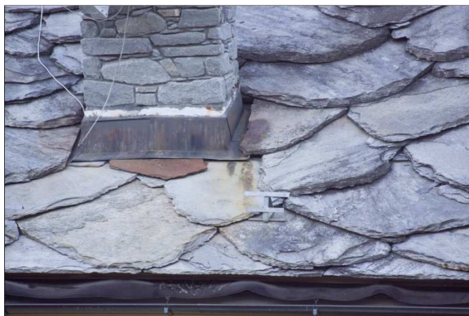
Figura 152 – Particolare della variazione di colore delle lose tendenti dal giallo al nero –
