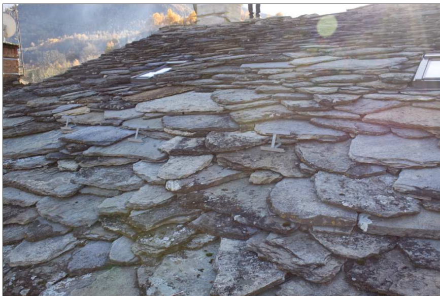
Figura 163 – Stato di conservazione ottimale per la falda esposta a Nord –
