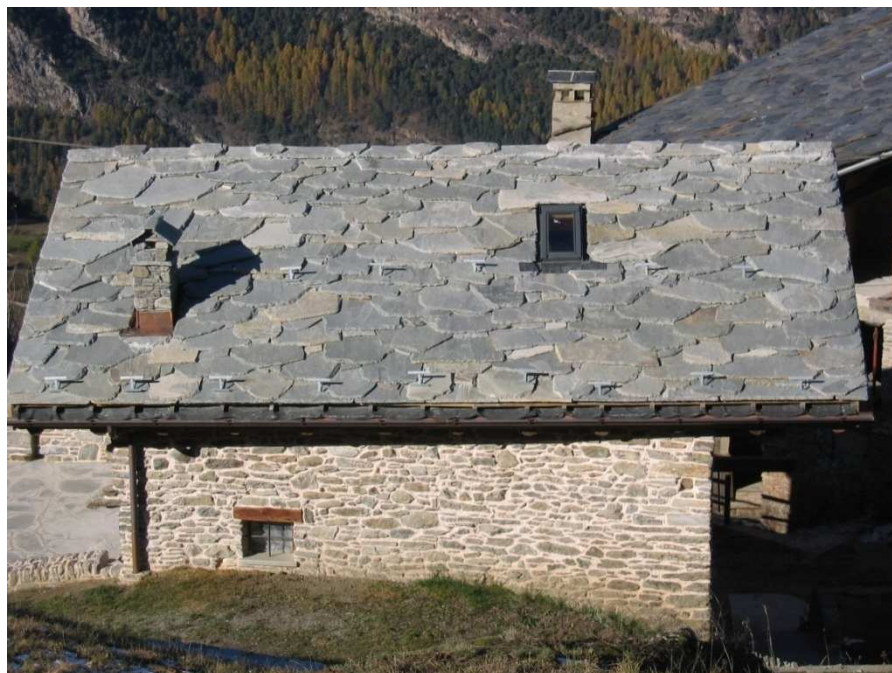
Figura 47 - Copertura di recente fattura con manto realizzato secondo la tecnica antica -
