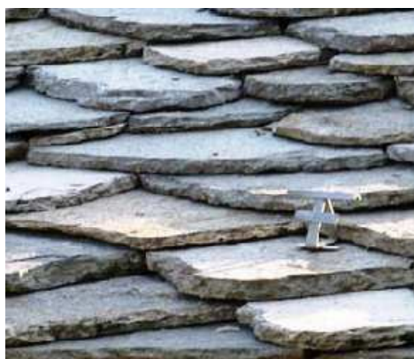
Figura 115 – Lose in ottimo stato di conservazione –
