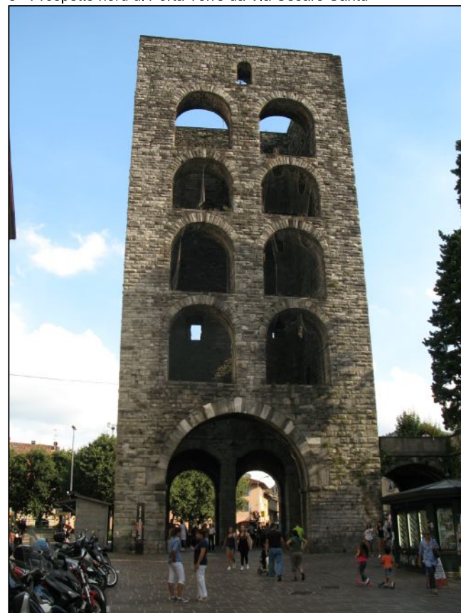
5 - Prospetto nord di Porta Torre da Via Cesare Cantù
