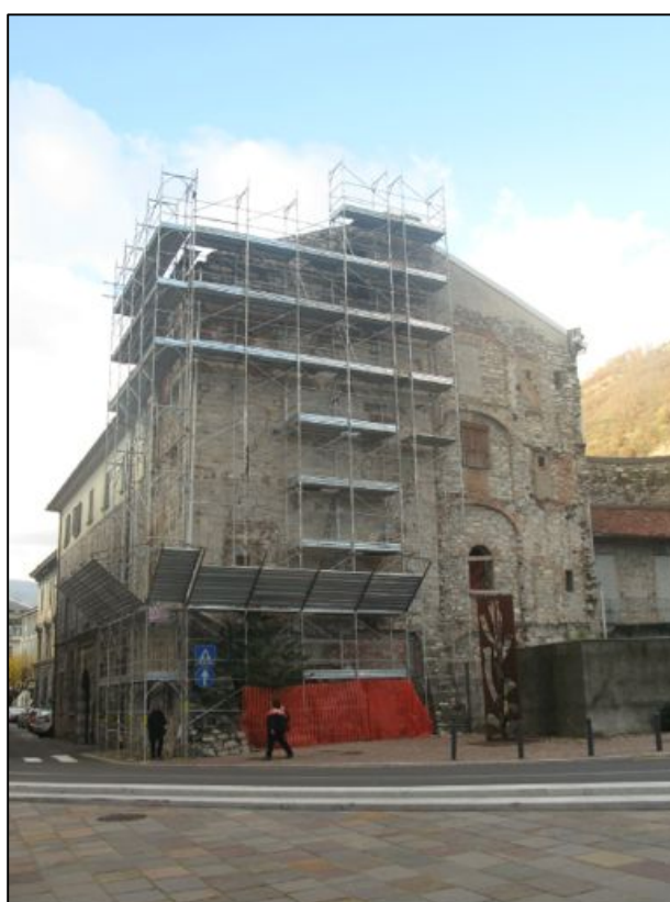
2 - Prospetto sud di Torre Pantera su Piazza Verdi
