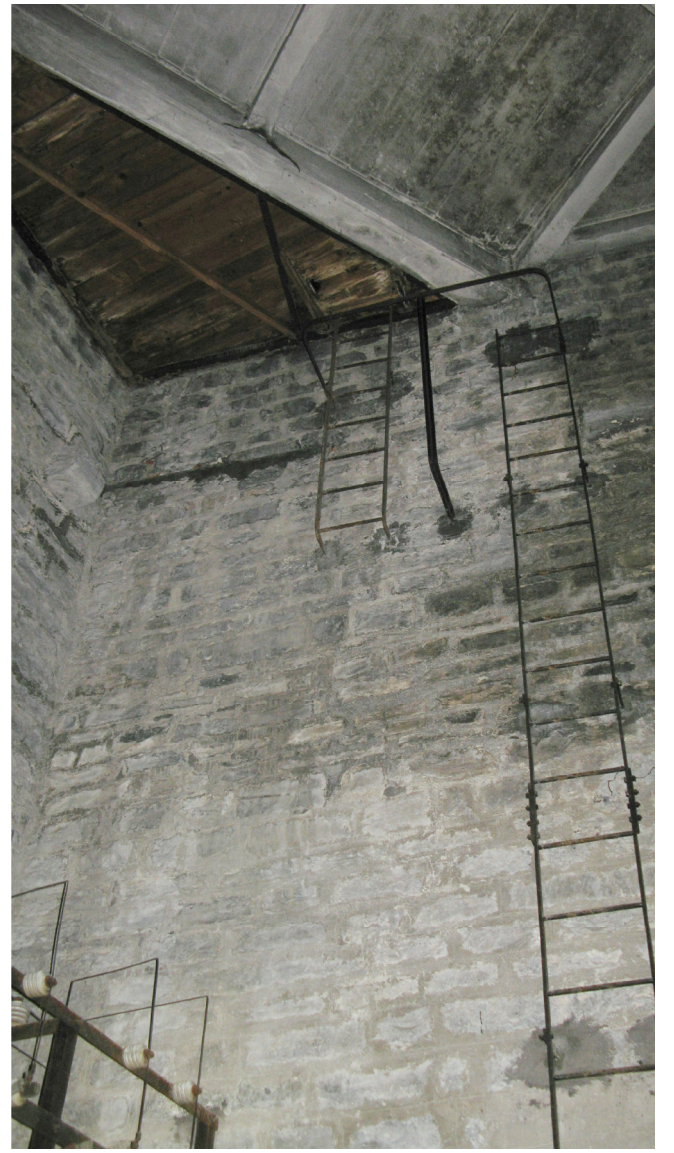
3- Parete ovest del vano con scala murata e botola in legno nello spigolo ovest del solaio. 22.09.2011
