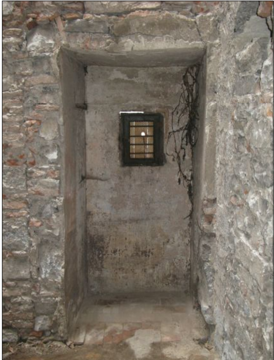
8 - BASSO - Nicchia d'apertura attualmente murata
