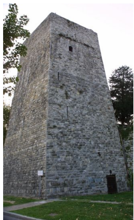
Torre San Vitale Altezza edificio: 27.95 m
