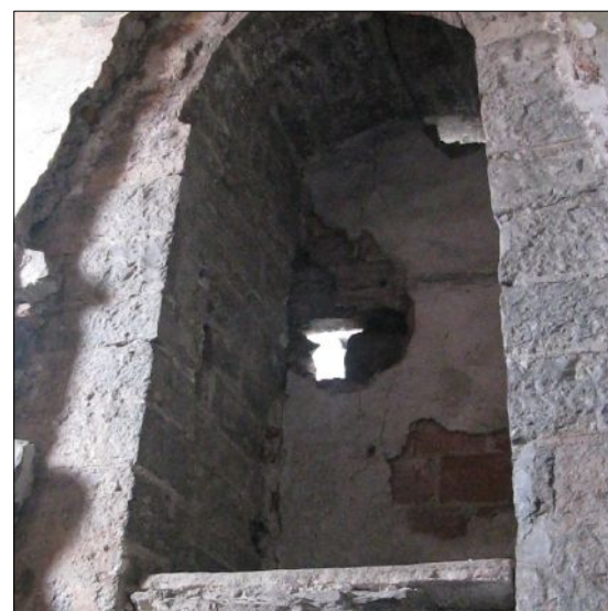
4- Vista delle nicchia presente nel muro di spina della torre verso il vano scale. Da tale apertura è stato possibile misurare lo spessore del muro
