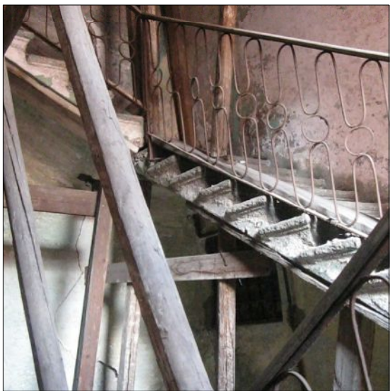
1- Vista a livello, si evidenzia lo spessore dell'alzata e della pedata nonché l'apertura all'ammezzato tra il piano terra e il piano primo
