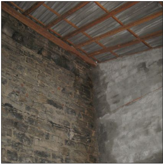
5- Vista verso l'alto dall'ultimo livello: si nota la copertura del vano scale costituita da una doppia orditura lignea e lastra ondulata in fibrocemento che funge da strato di tenuta
