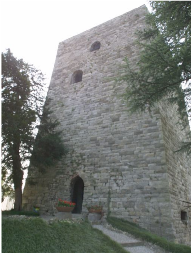
1- Prospetto Nord presso il Giardino Mantero, accesso al livello quota mura della Torre Gattoni. 29.09.2011
