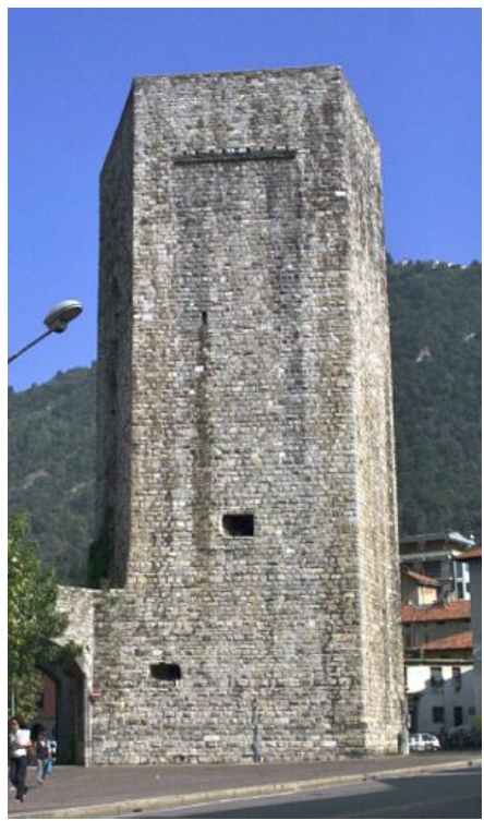
Torre San Vitale Altezza edificio: 32.75 m
