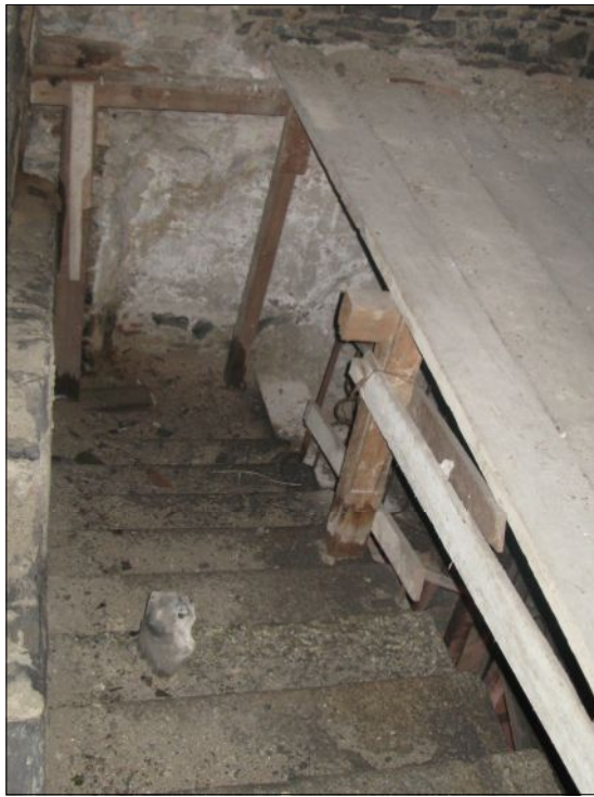
6 - Vista dell'ultima rampa presente all'ultimo livello del vano scale: in sommità è stato realizzato un piano provvisorio con assi di legno sp. 25 mm
